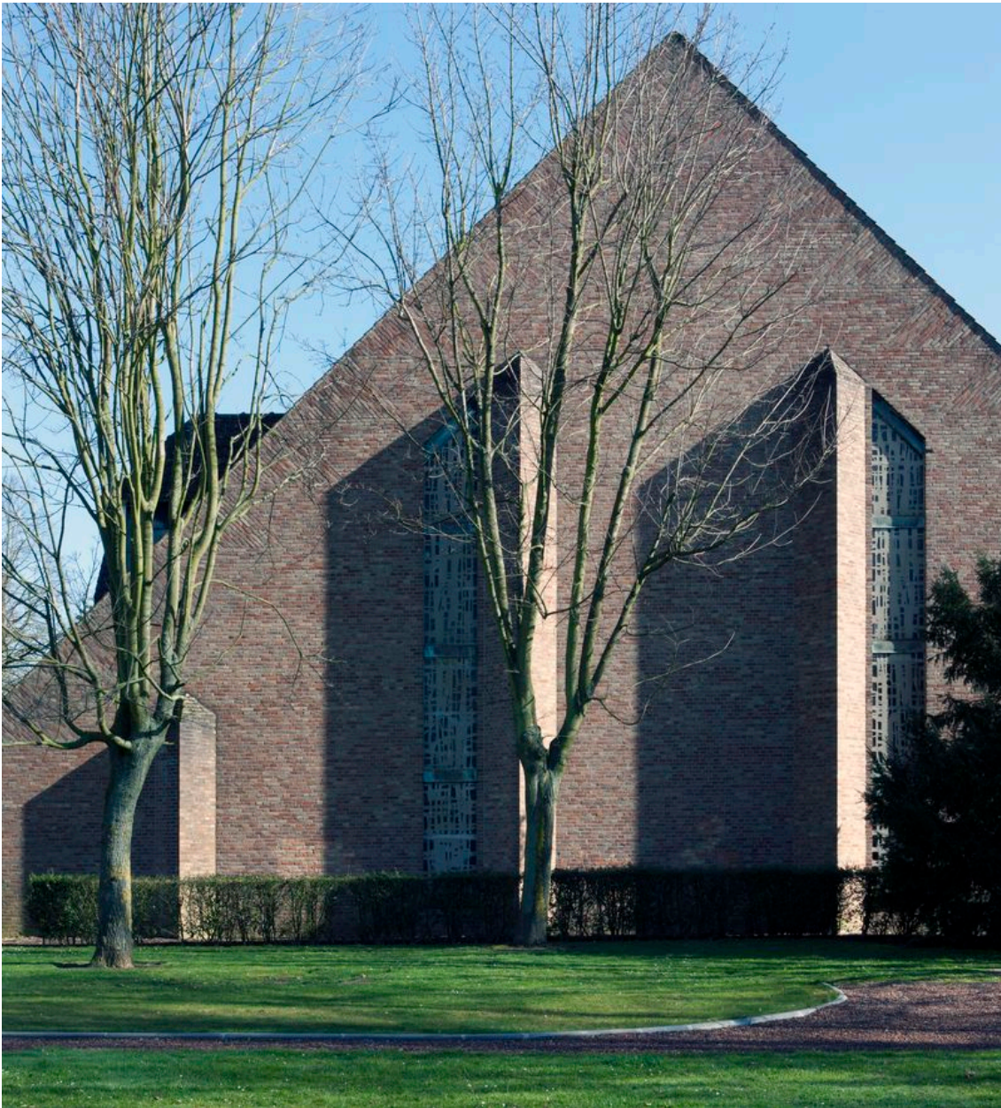
Contrefort de l'élévation sud.
