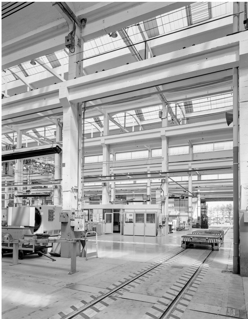
Vue générale intérieure de la structure en béton des halles 20 à 23 nord.
