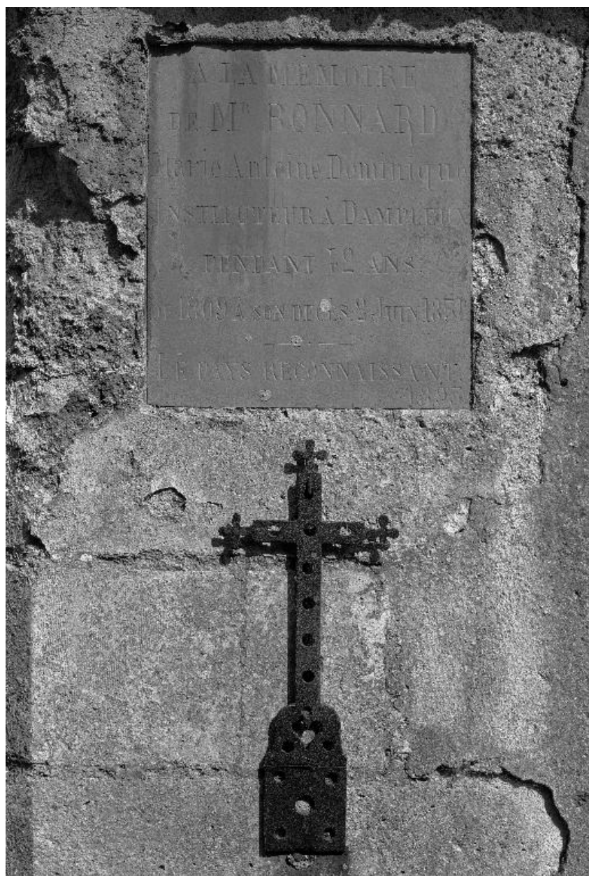
Détail de l'élévation occidentale du bras sud du transept : vue de la plaque commémorative en calcaire, offerte par la commune en mémoire de M. Bonnard, instituteur à Dampleux de 1809 à 1851.
