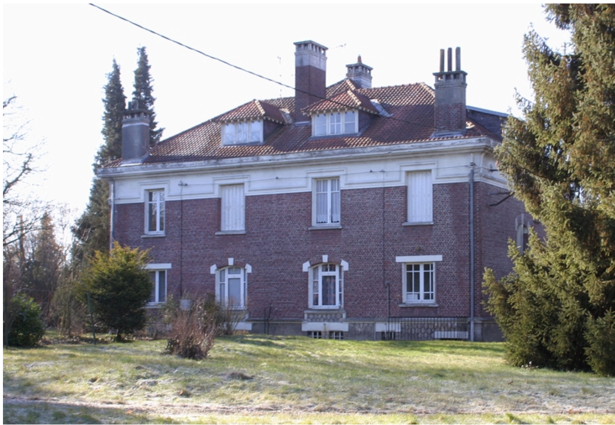
Bâtiment à deux logements de 1926-1928, façade postérieure.
