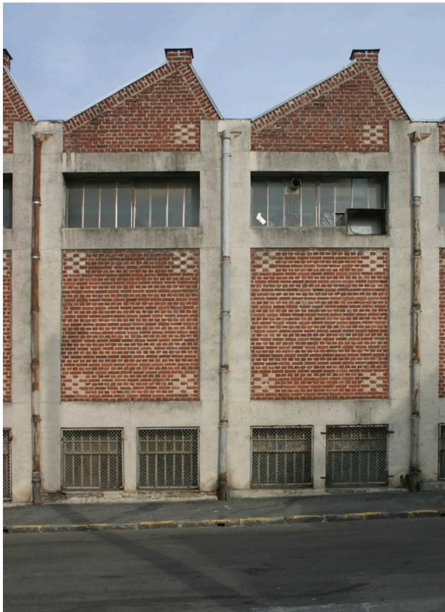
Détail des ateliers, rue Félix-Davin.
