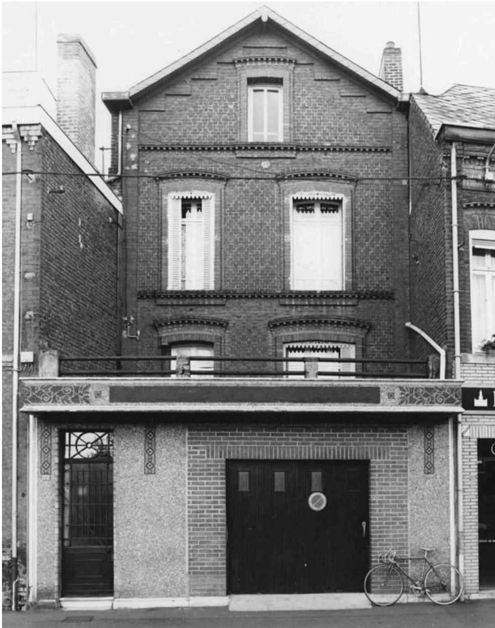
Vue de la maison, précédée de l'ancienne boucherie.
