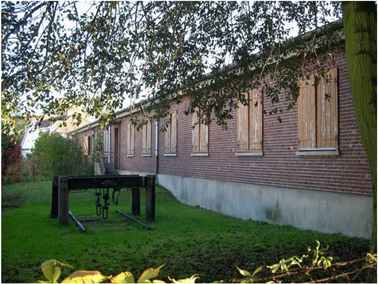
Ecole de la SNCF, vue depuis le sud-ouest.
