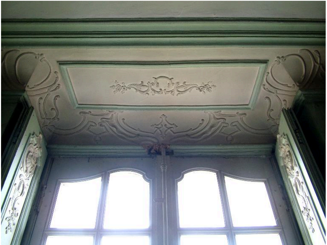
Chambre du premier étage de la travée centrale du logis : corniche et volets intérieurs de la fenêtre.
