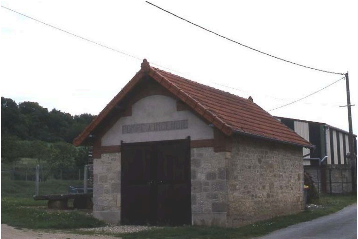
Vue du bâtiment de la pompe.
