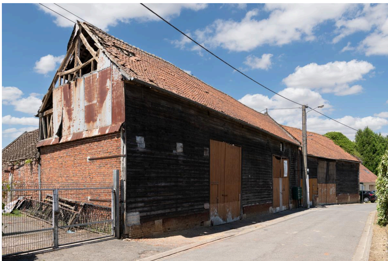
Anciennes granges sur rue, n°9-13 rue Jeannette, vue depuis l'est.
