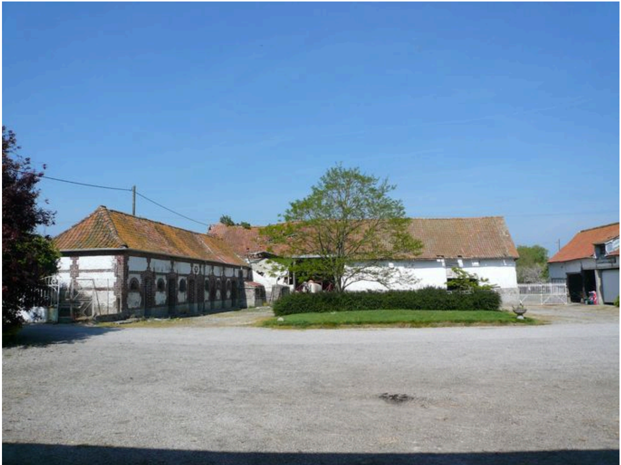
Vue des porcheries le long de la rue (à l'ouest) et de la grange au nord.
