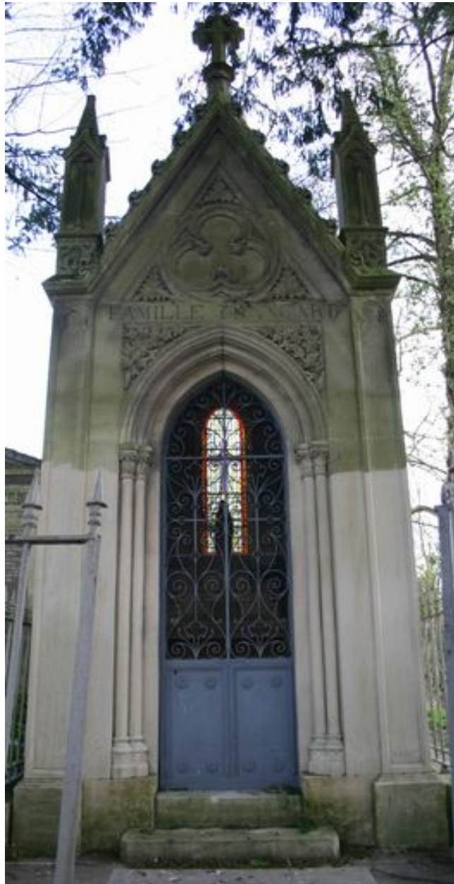
Vue rapprochée de la façade principale.
