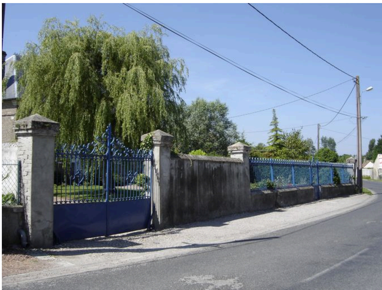
Mur de clôture avec piliers d'entrée
