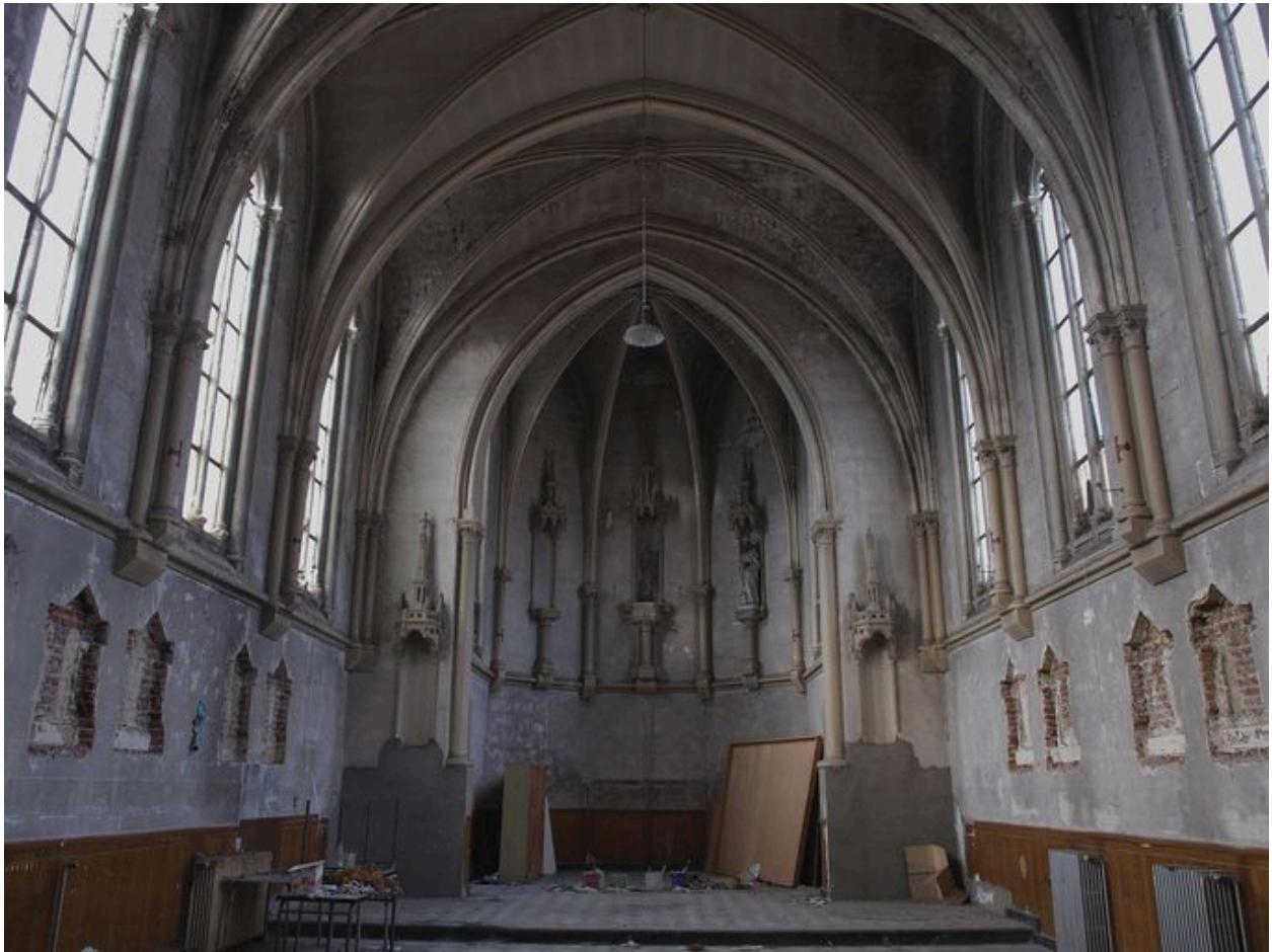
Chapelle, intérieur : vue d'ensemble du chœur (intérieur)
