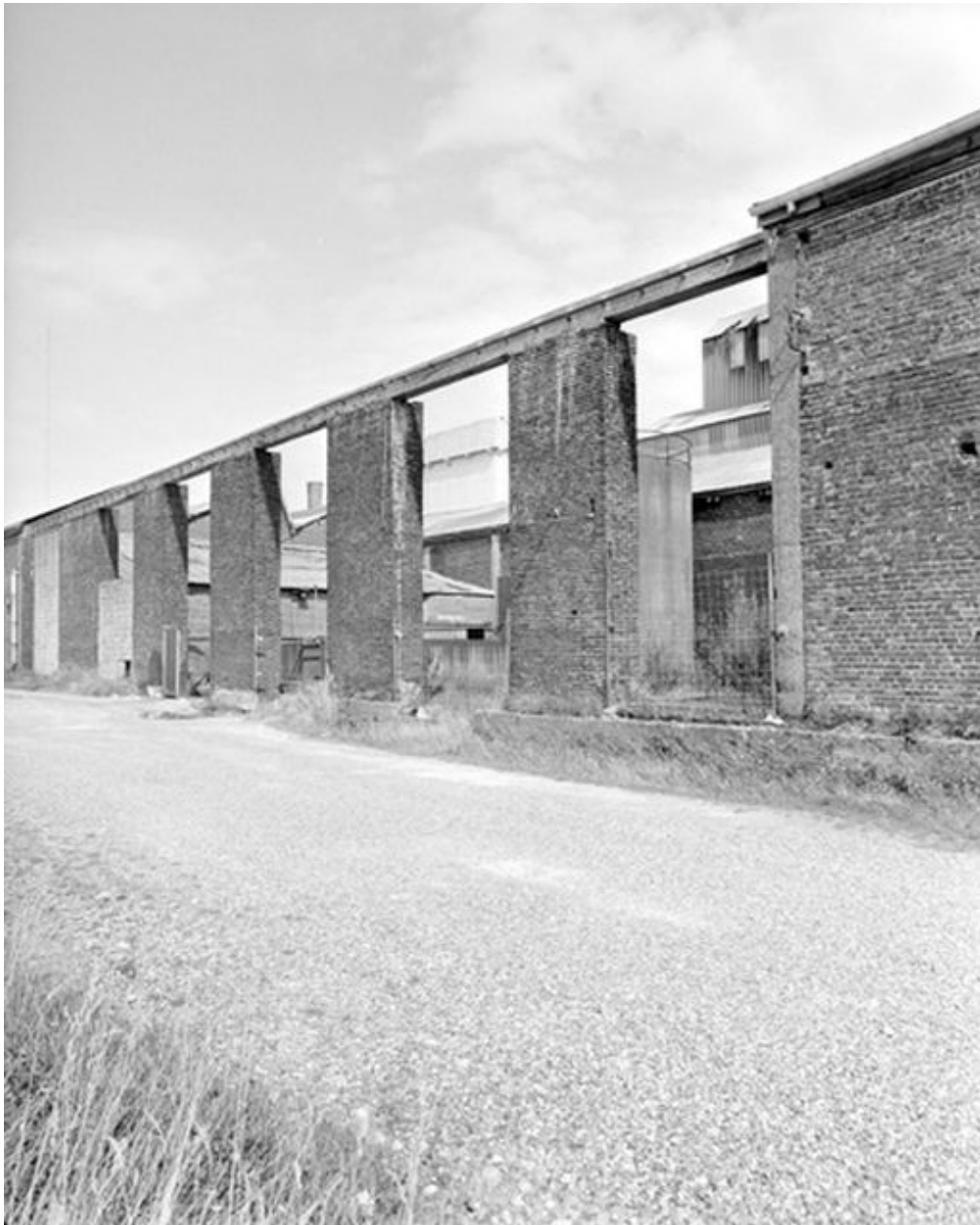
Vue partielle des ateliers de fabrication.
