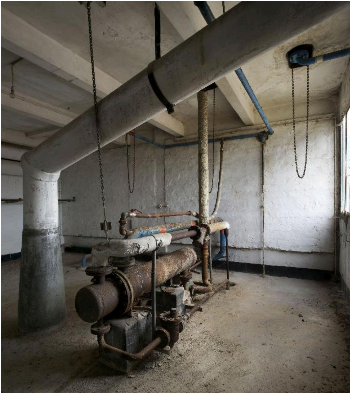
Calorifère au 3e étage de la brasserie.
