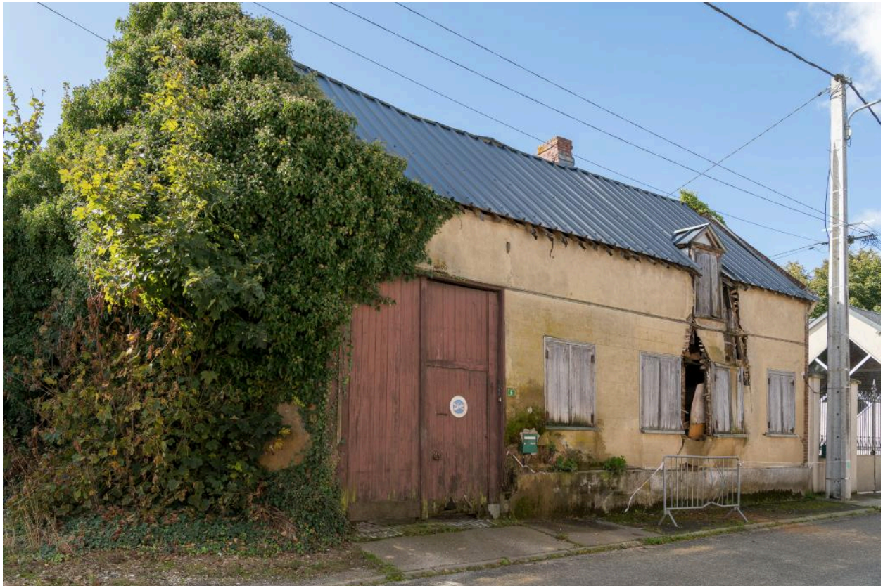
Ancien logis ou atelier sur rue (?), n°6 rue de la Mairie, vue depuis le nord-est.
