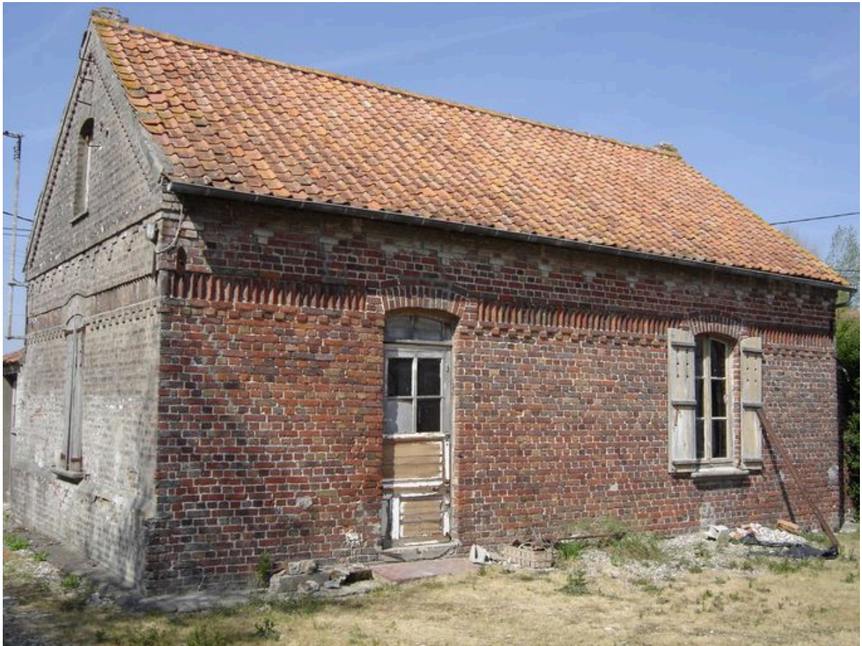
Vue du logement annexe depuis la cour.
