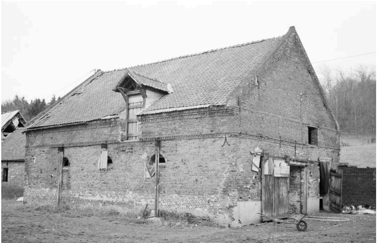
Bâtiment agricole de la ferme de la sucrerie : façade sur cour.
