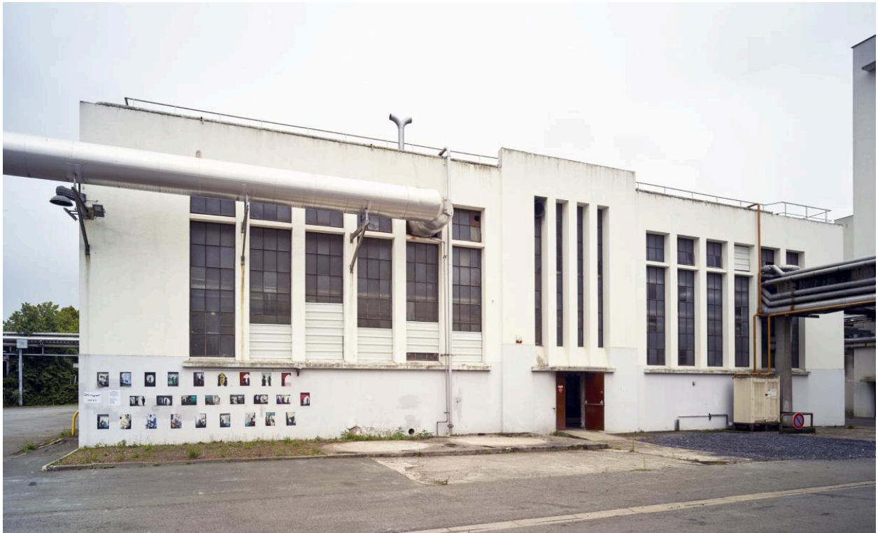
La chaufferie (A), élévation nord.
