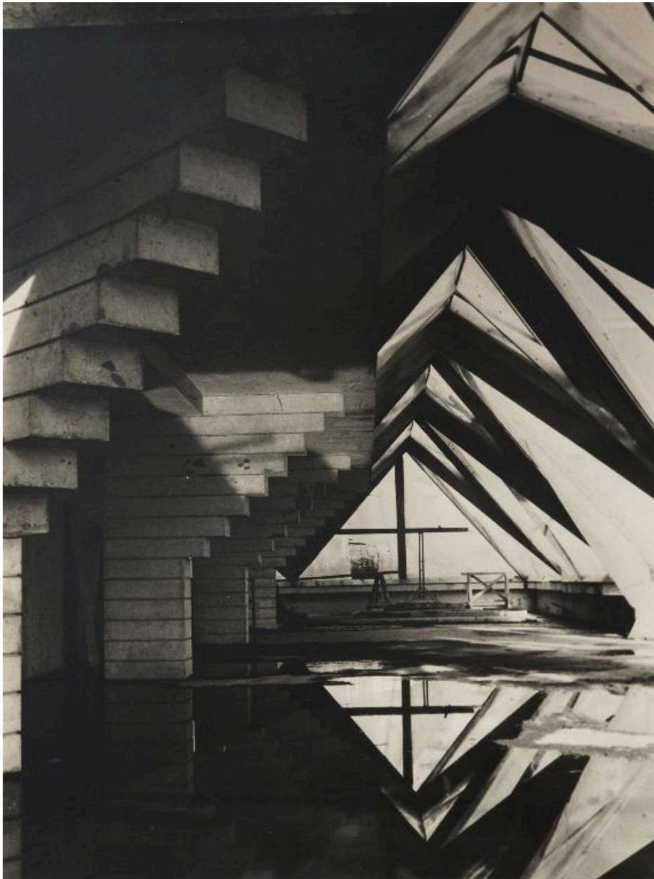
L'édifice en cours de construction. Vue du niveau inférieur. Photographie, vers 1970. AP Jean XXIII, Saint-Quentin.
