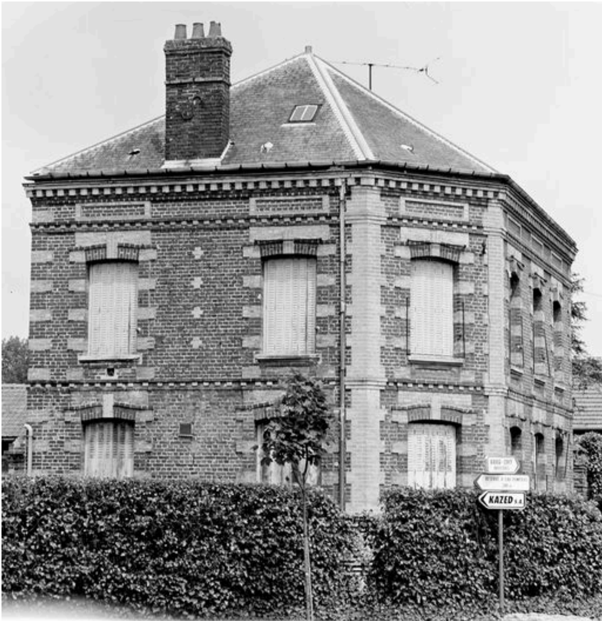
Logement patronal : élévation est.
