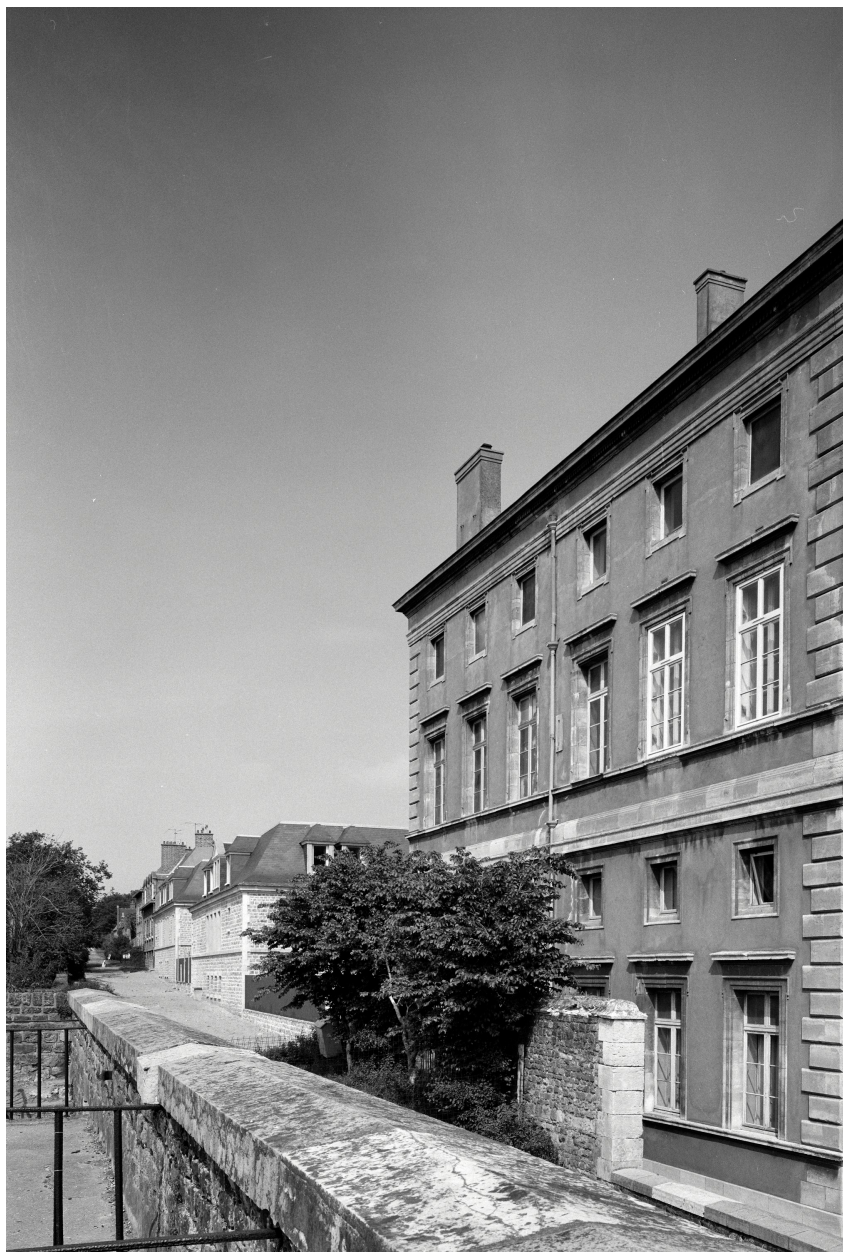
Palais de justice, façade sur les remparts.
