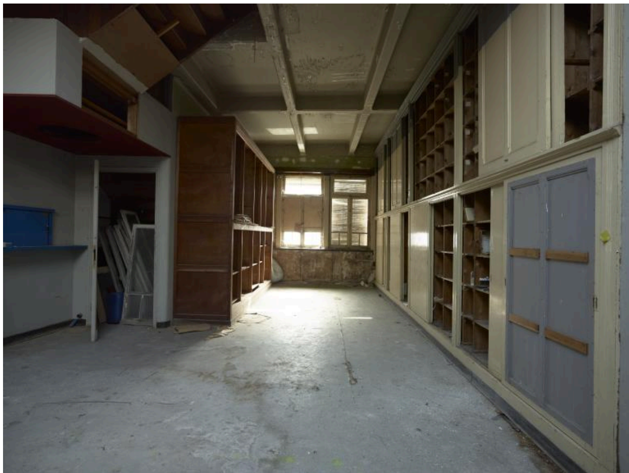
Bureaux. Salle des archives au premier étage.
