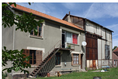
Vue d'ensemble. Phot. Bertrand Fournier IVR22_20098005107NUCA
