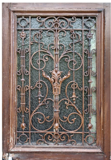
Détail de la grille en ferronnerie de la porte d'entrée sur rue. Phot. Bertrand Fournier IVR22_20098005115NUCA
