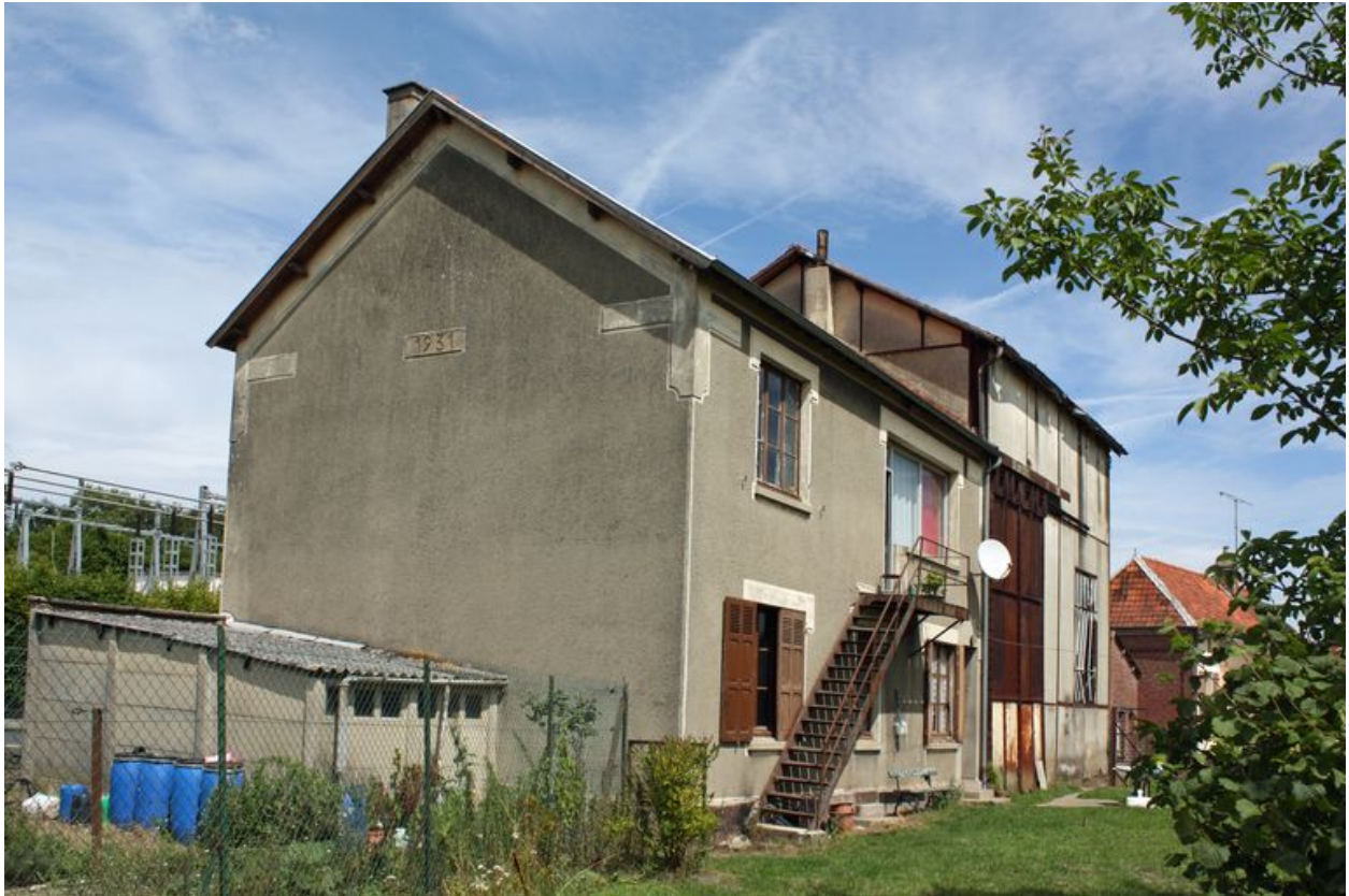
Vue d'ensemble postérieure.
