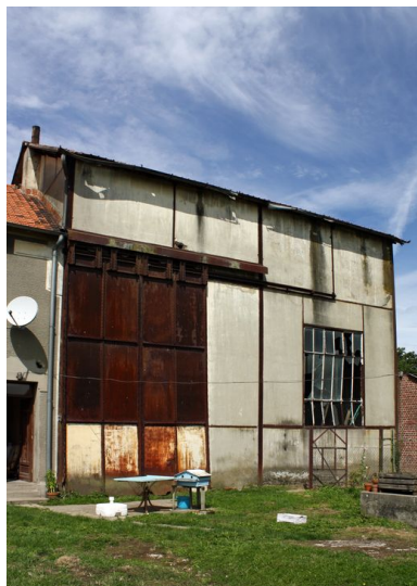
Atelier de réparation, façade arrière. Phot. Bertrand Fournier IVR22_20098005110NUCA
