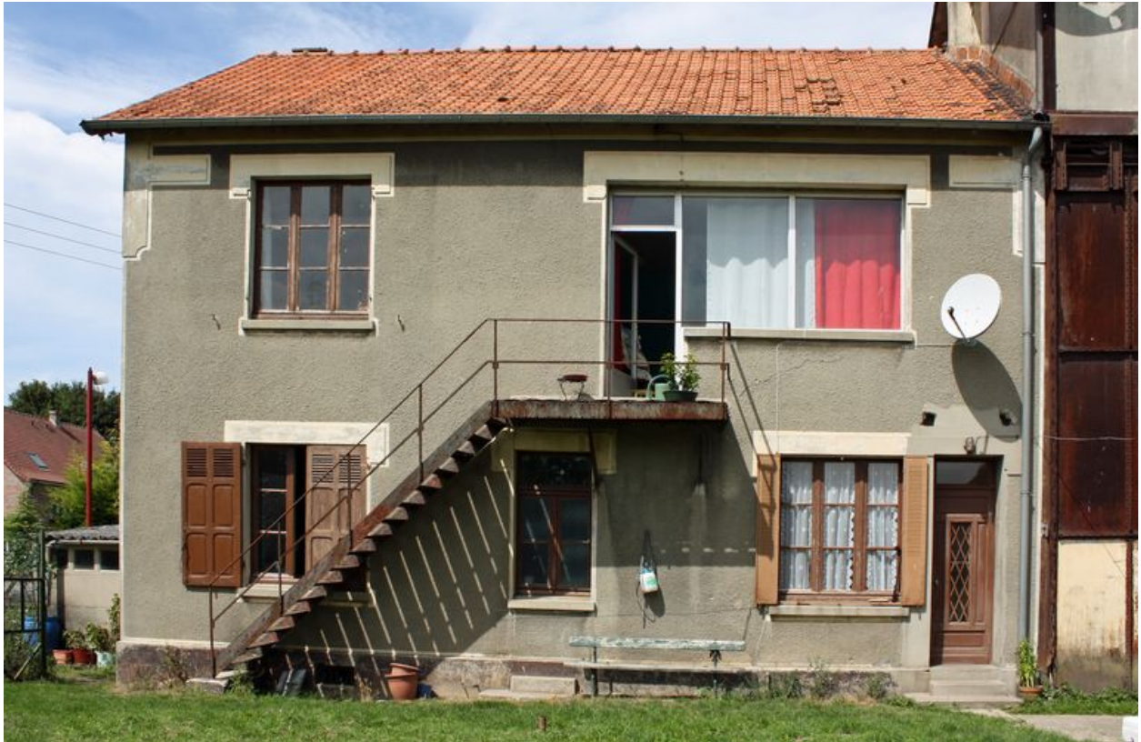
Logement et bureaux, façade postérieure.
