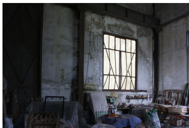
Intérieur de l'atelier de réparation, vue d'ensemble. Phot. Bertrand Fournier IVR22_20098005111NUCA
