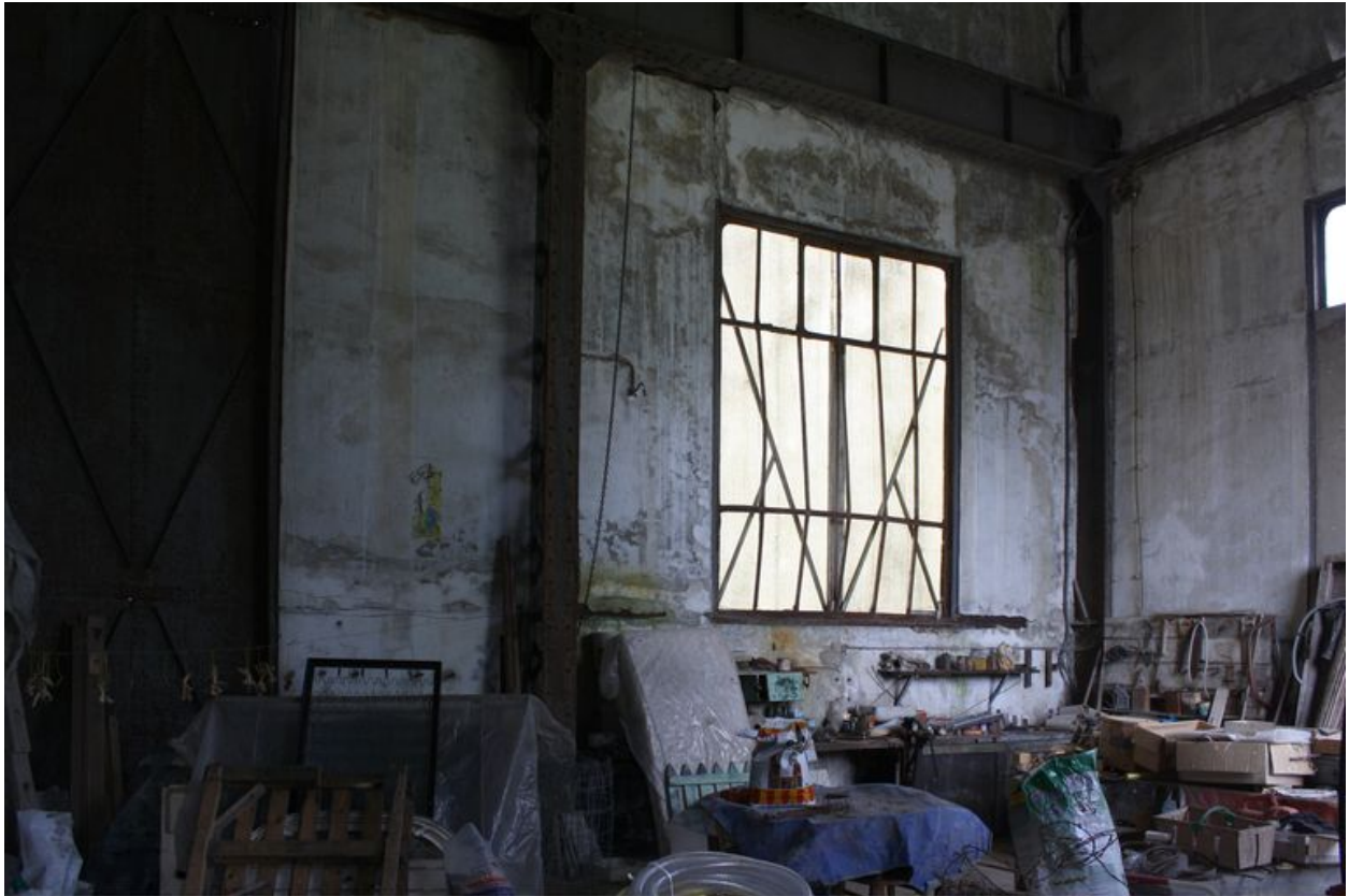
Intérieur de l'atelier de réparation, vue d'ensemble.
