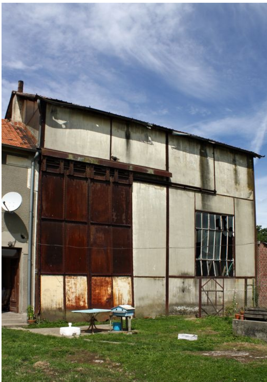
Atelier de réparation, façade arrière.
