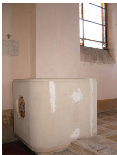
Vue latérale de la chaire à prêcher. Phot. Irwin Leullier IVR22_20050200986NUCA
