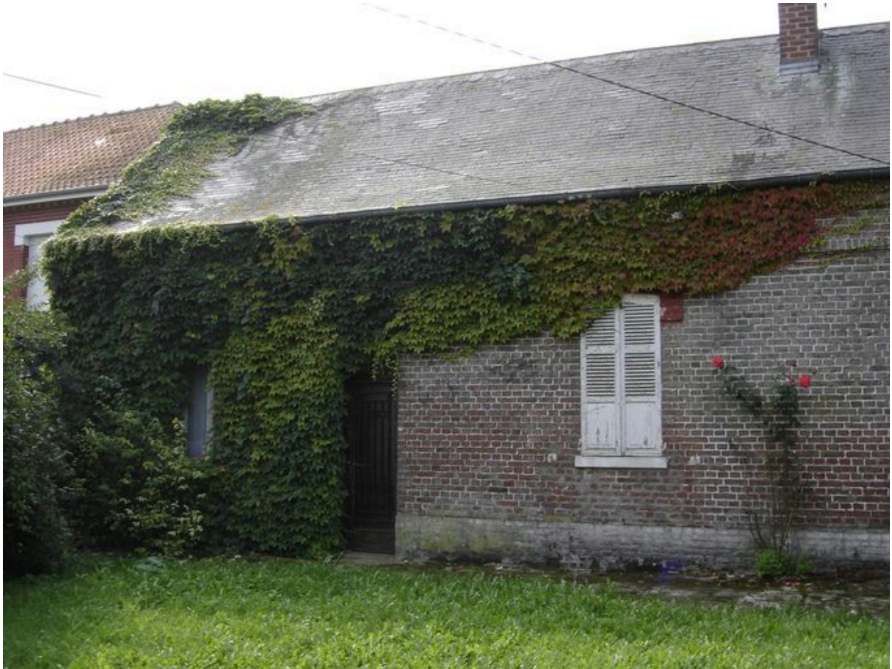
Vue de la partie est de celle-ci.
