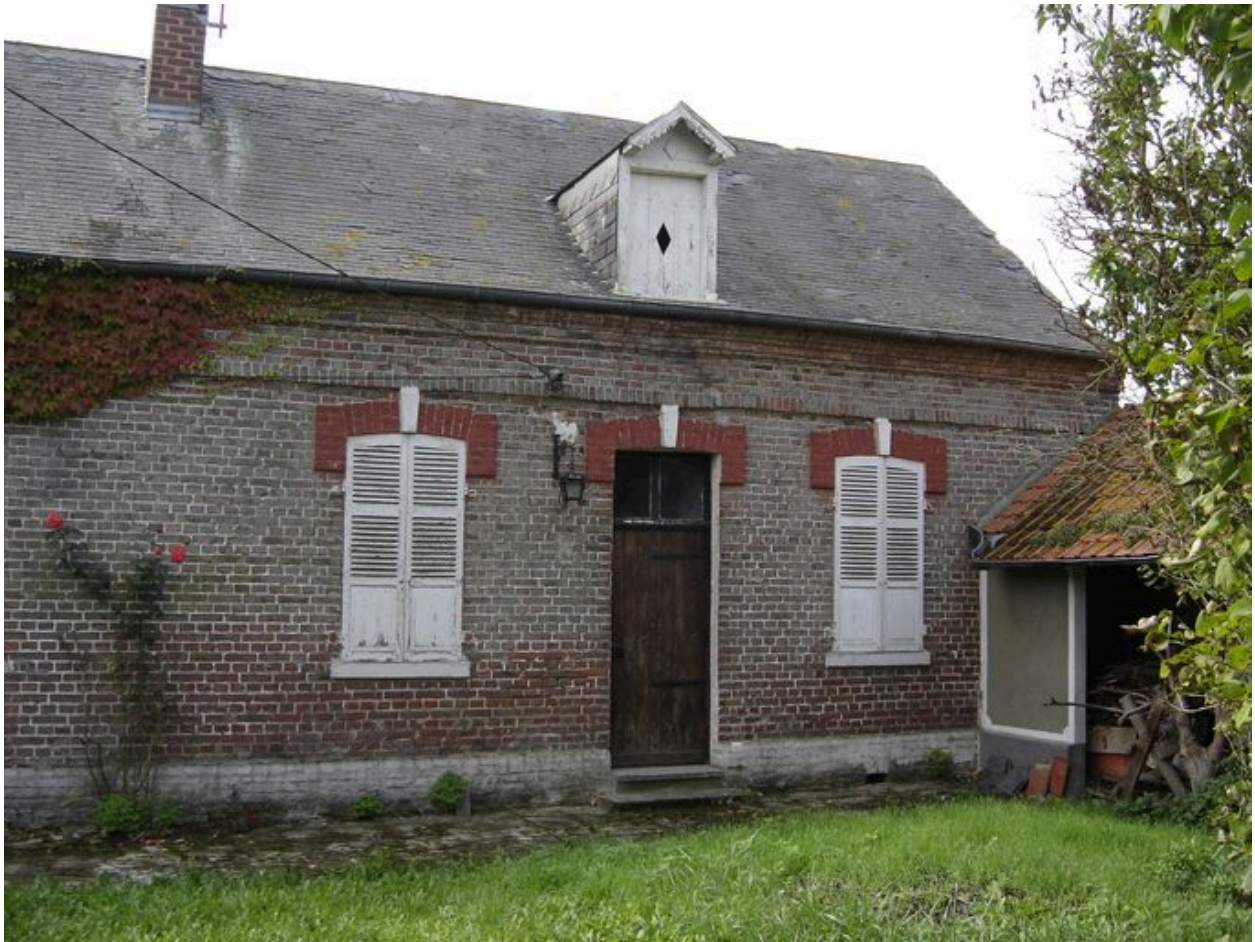
Vue de la partie ouest de l'habitation.
