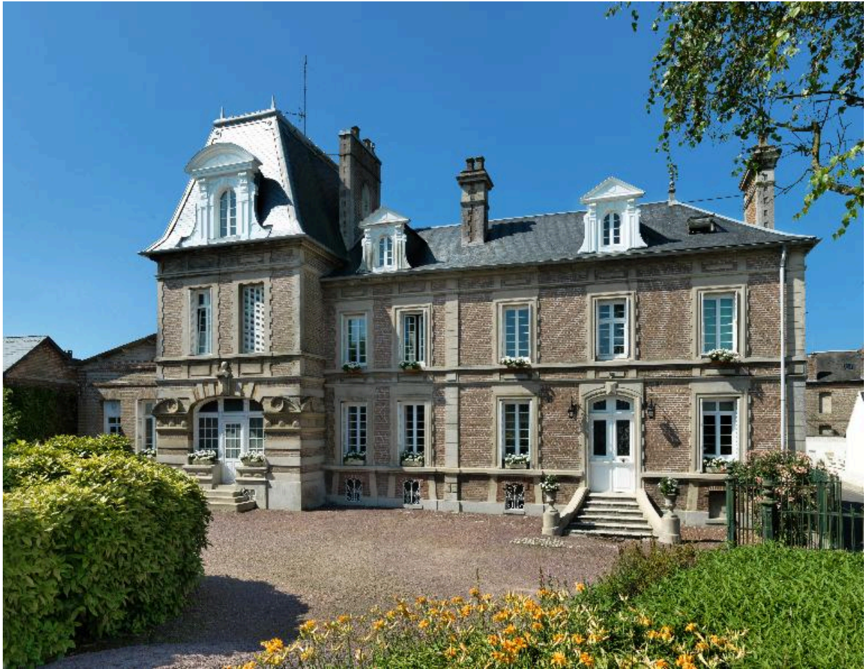
Vue de la façade antérieure.
