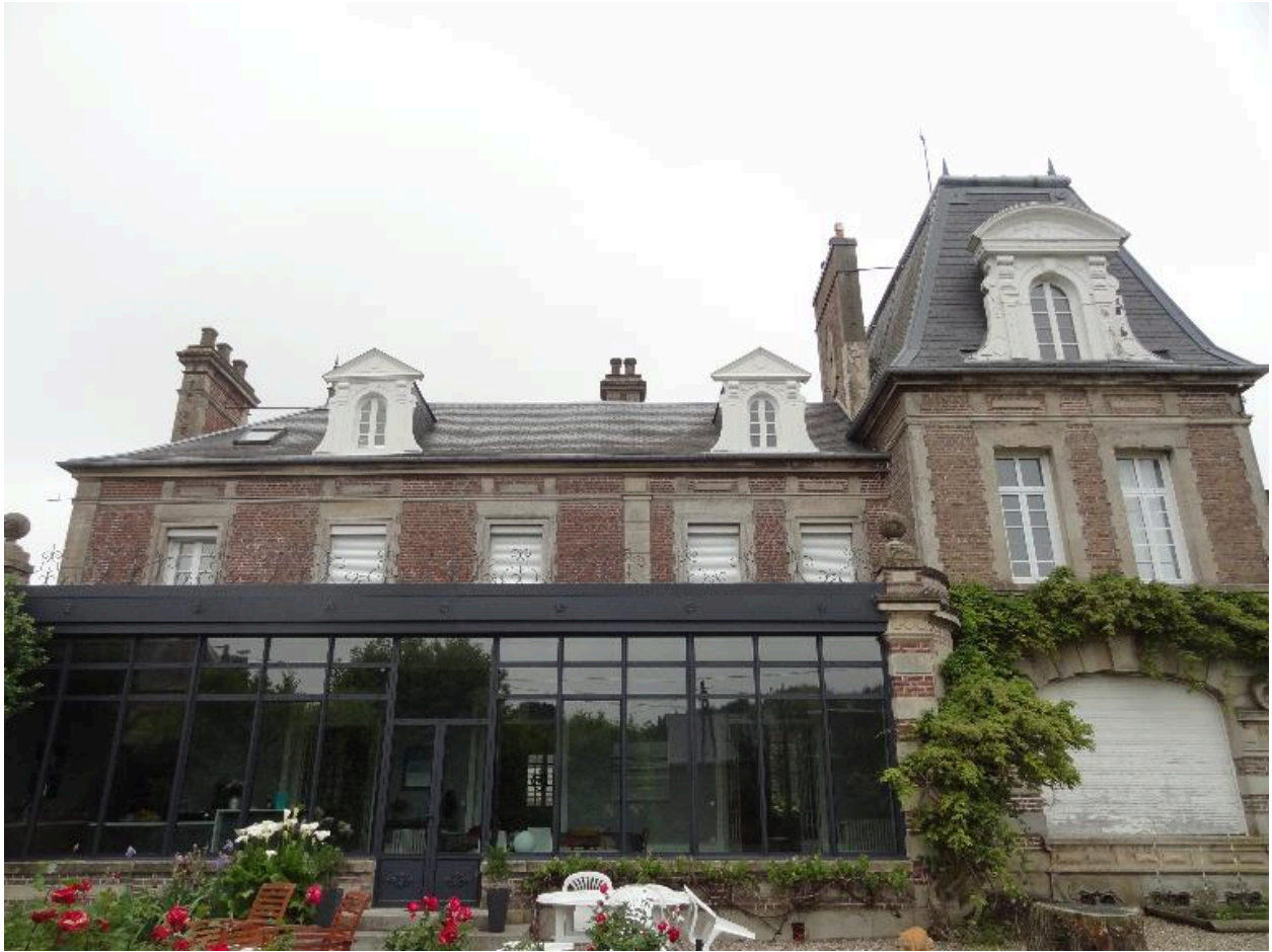
Vue de la façade postérieure.
