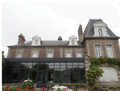
Vue de la façade postérieure. Phot. Frédéric-Nicolas Kocourek IVR22_20148005051NUC2A
