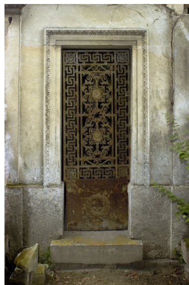
Vue de la porte en fonte. Phot. Thierry Lefébure IVR22_20058001093NUCA
