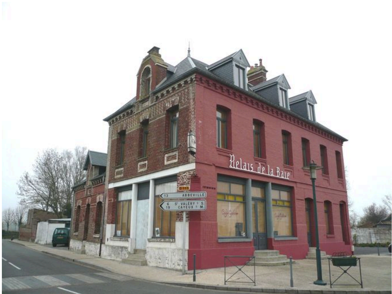
Vue de face de l'ancienne partie hôtel.
