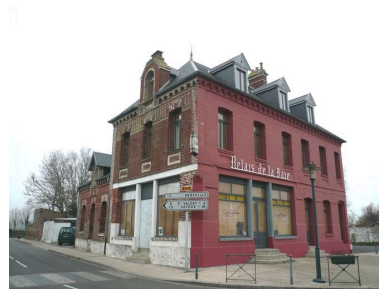
Vue de face de l'ancienne partie hôtel.
