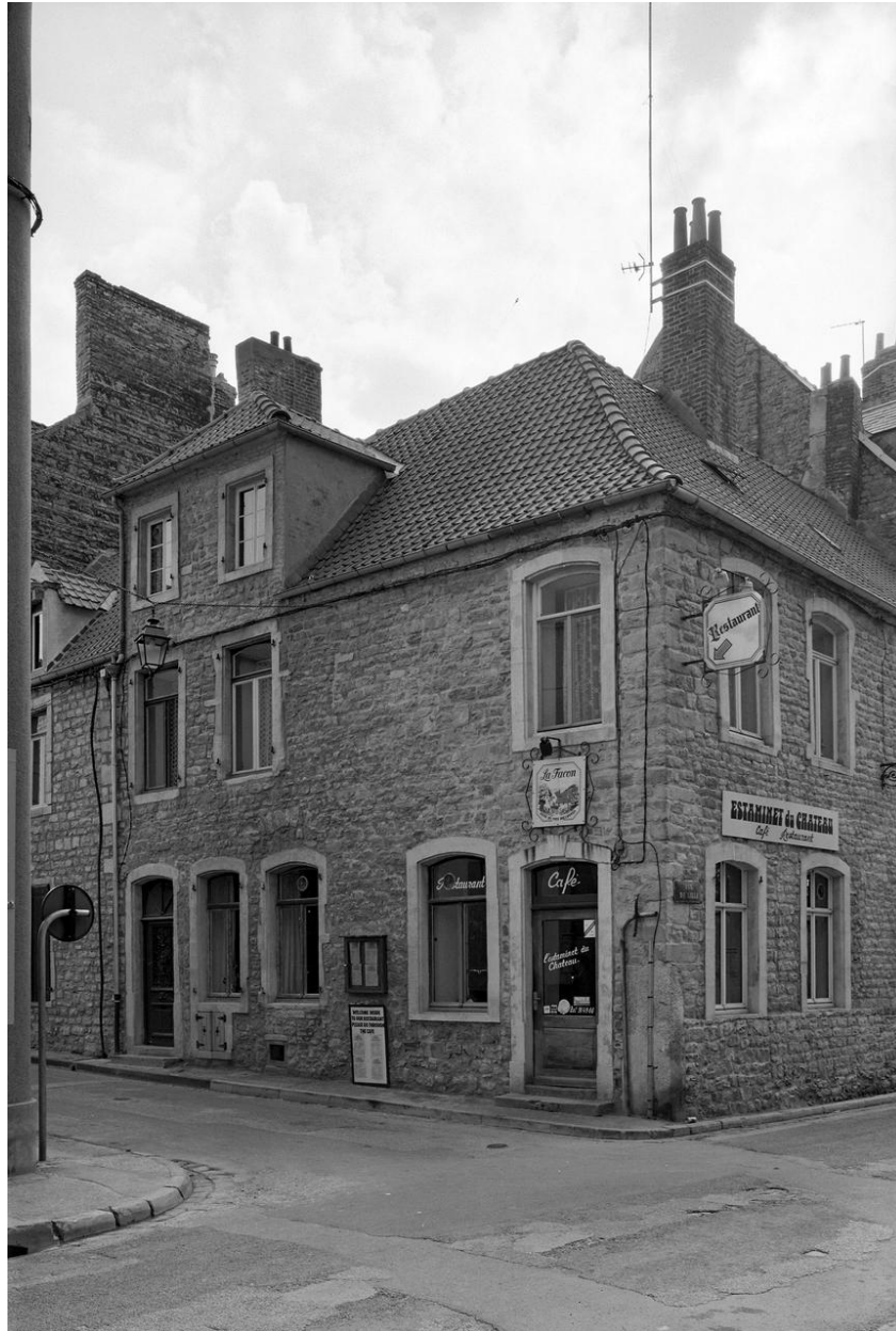
Vue générale après restauration.
