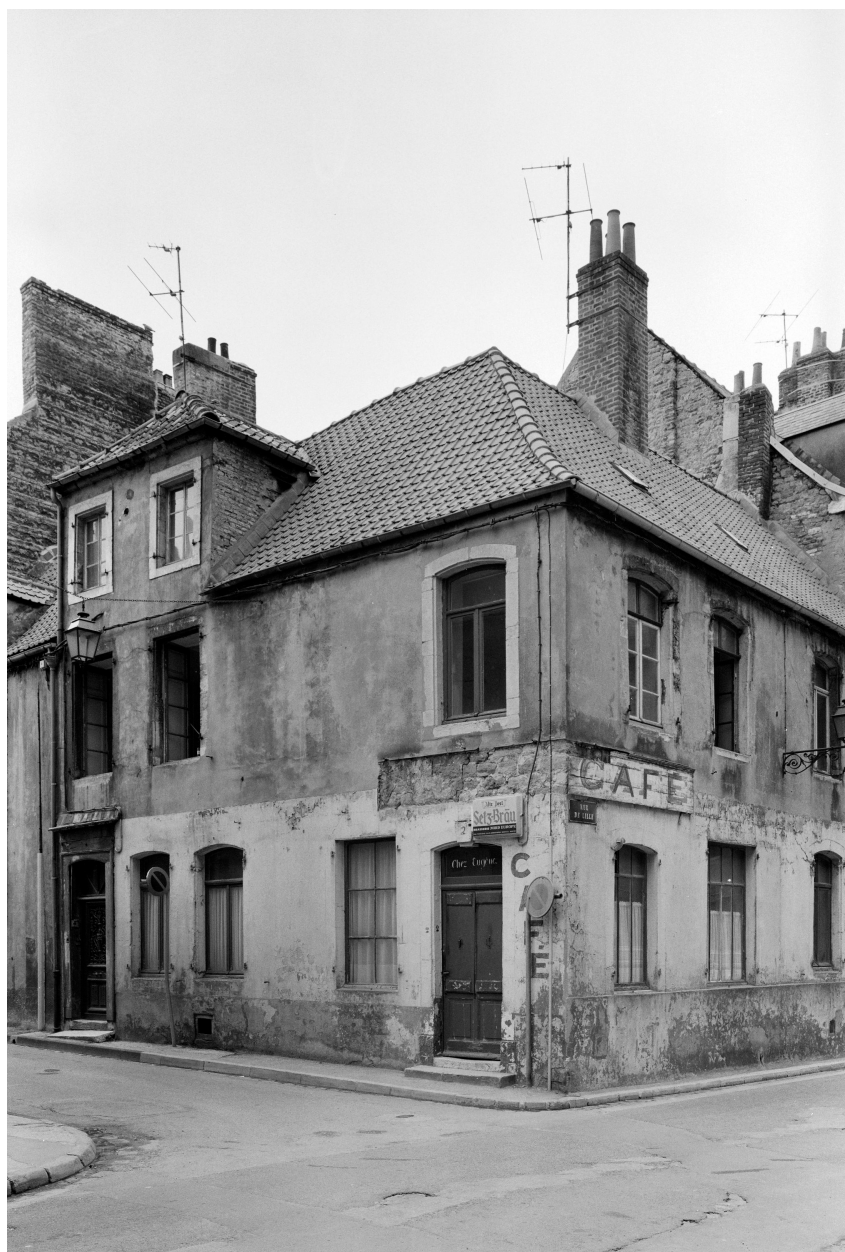
Vue générale avant restauration.
