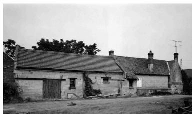
Second logis, four et étables. Elévation postérieure. Phot. Jean-Michel Perrin IVR22_19846001104X
