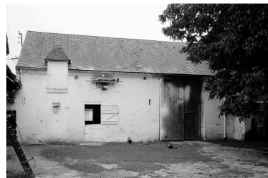
Etable et grange en fond de cour. Elévation antérieure. Phot. Jean-Michel Perrin IVR22_19846001159X
