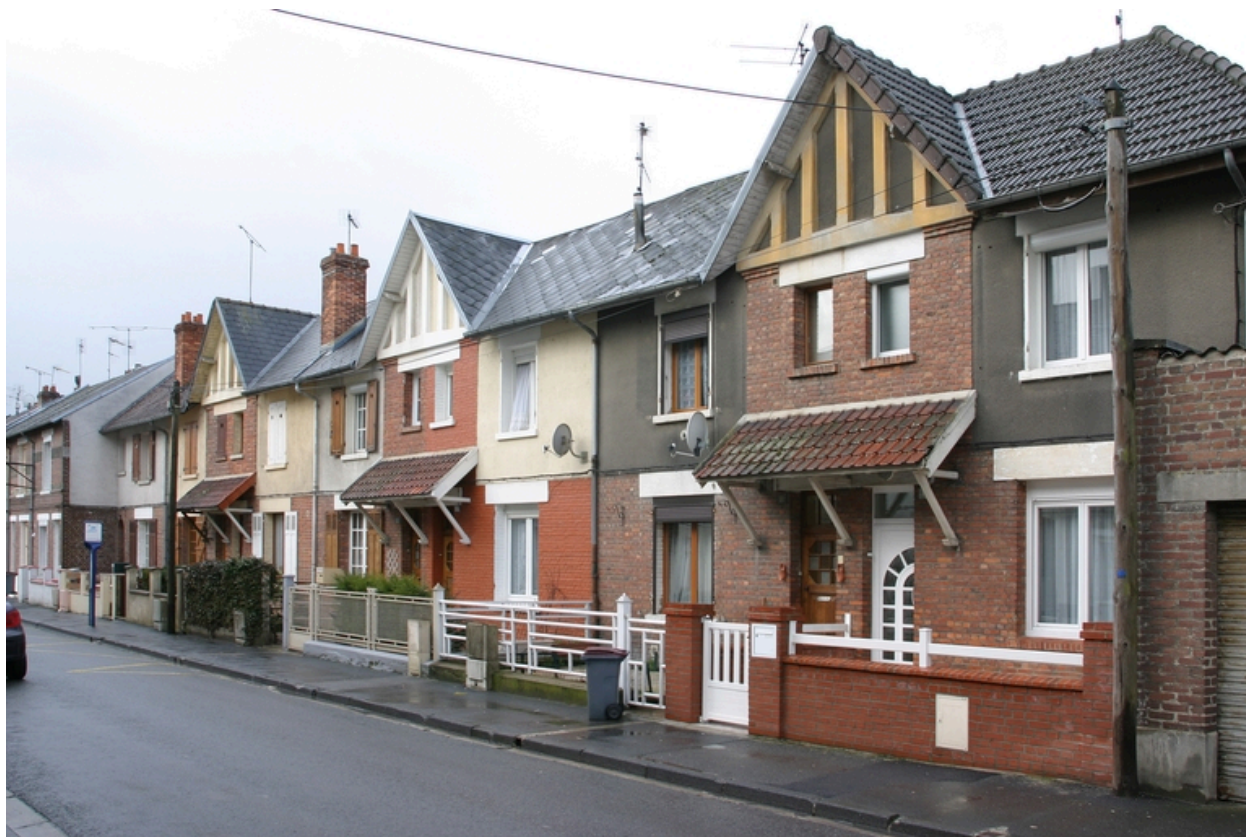
Logements de type B, chemin Clastrois.
