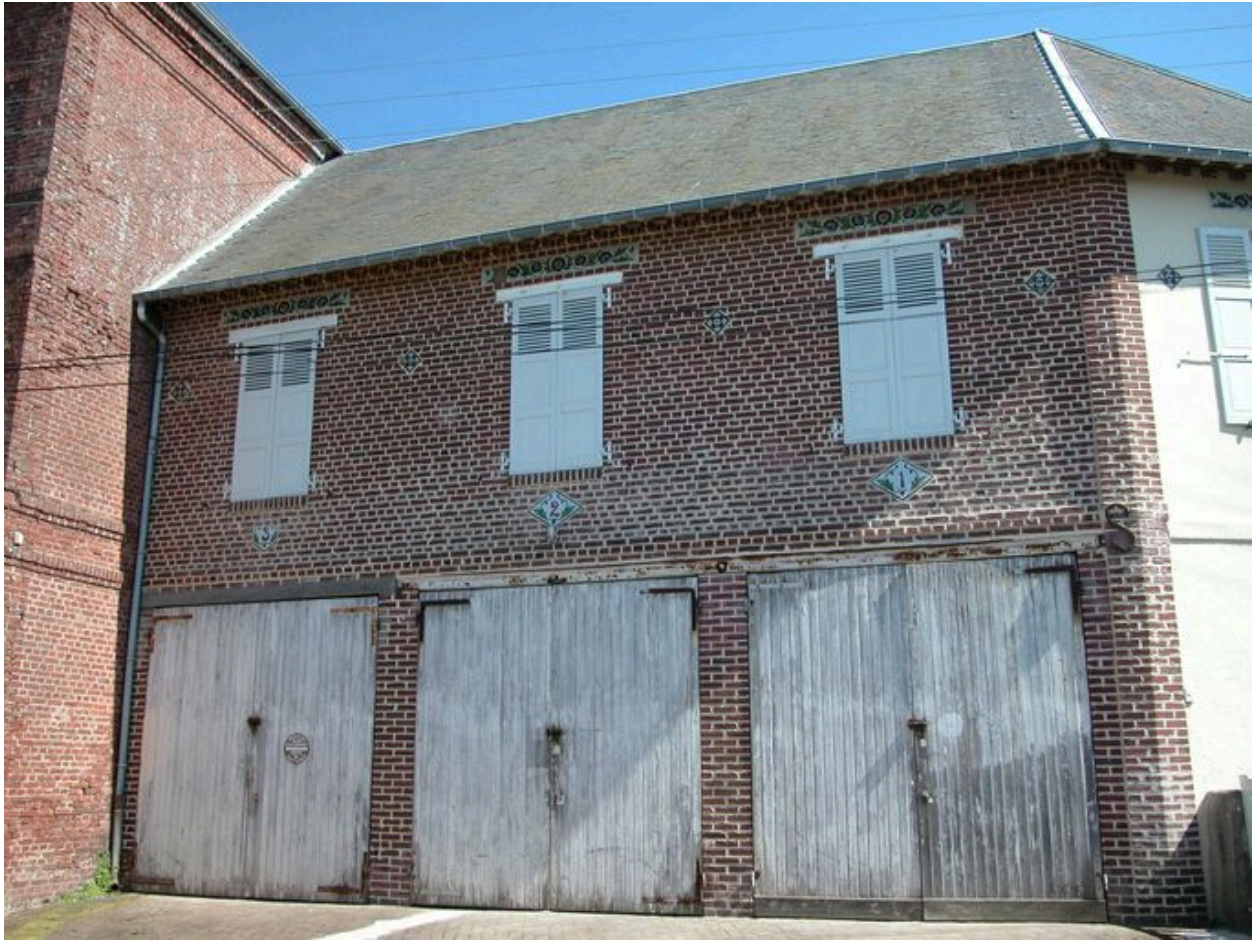
Vue des garages, depuis la rue Gros.
