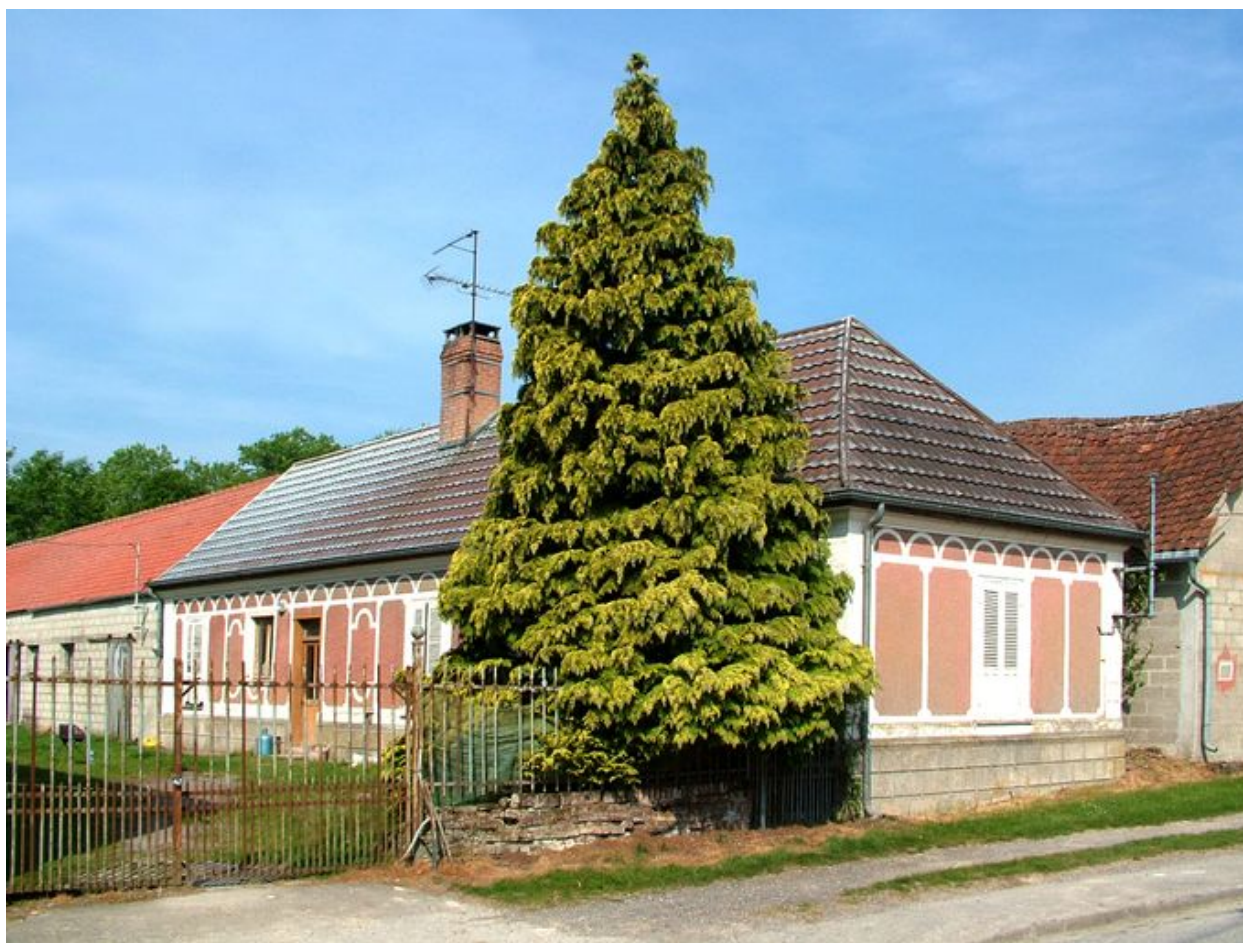
Ancienne ferme, 9 rue Principale, 19e siècle.
