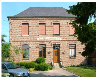
La mairie de Surcamps (ancienne école et mairie). Phot. Frédéric Fournis IVR22_20108001366NUCA
