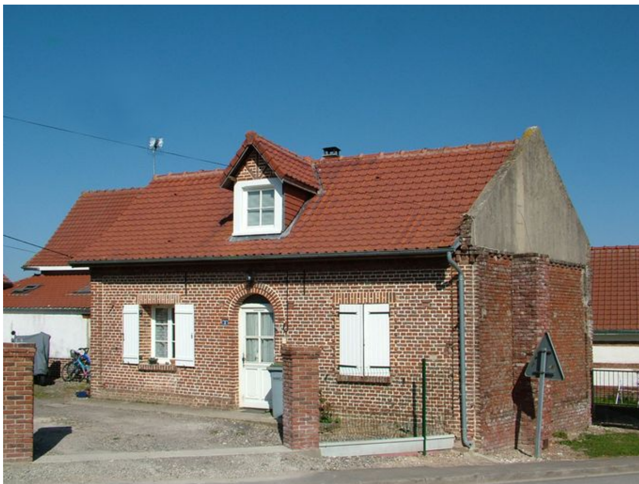
Maison, 2 rue Principale, fin du 19e siècle.
