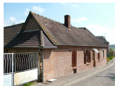
Maison, 16 rue de la Cavée, 2e moitié 19e siècle. Phot. Frédéric Fournis IVR22_20108001255NUCA
