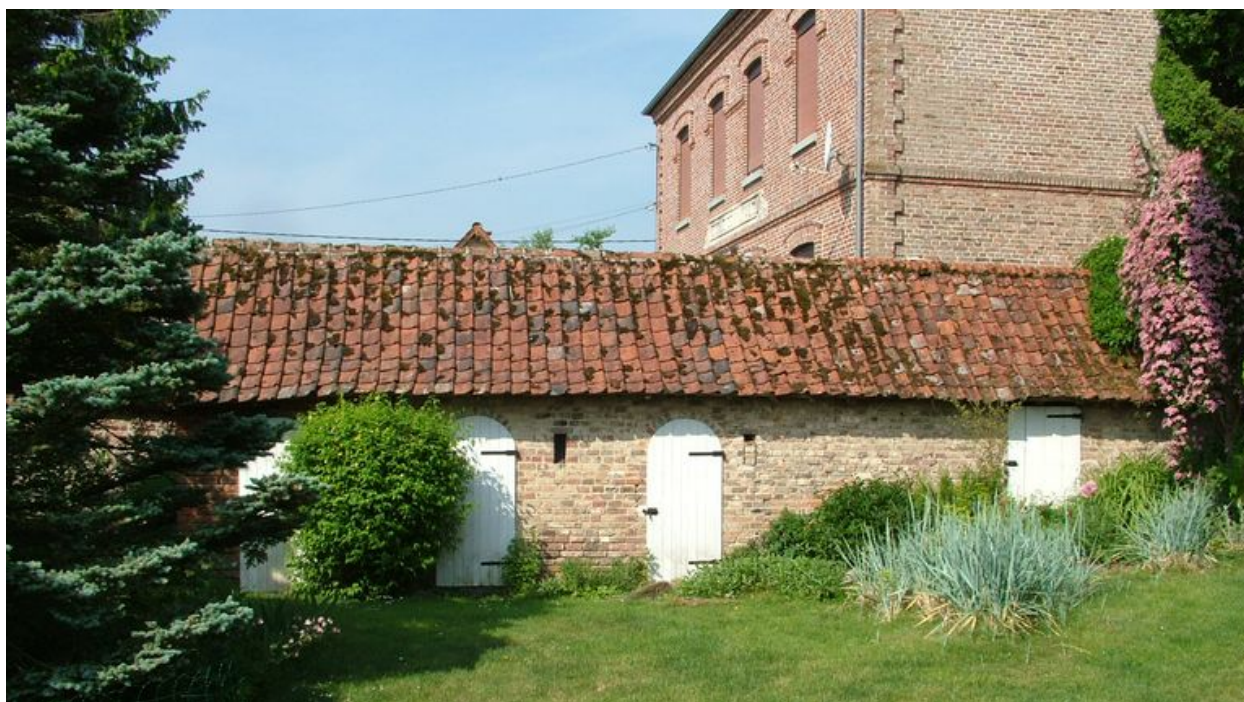
Ancienne étable, 18 rue d'En-Haut, 2e moitié du 19e siècle.
