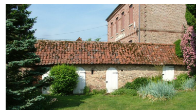
Ancienne étable, 18 rue d'En- Haut, 2e moitié du 19e siècle. Phot. Frédéric Fournis IVR22_20108001364NUCA
