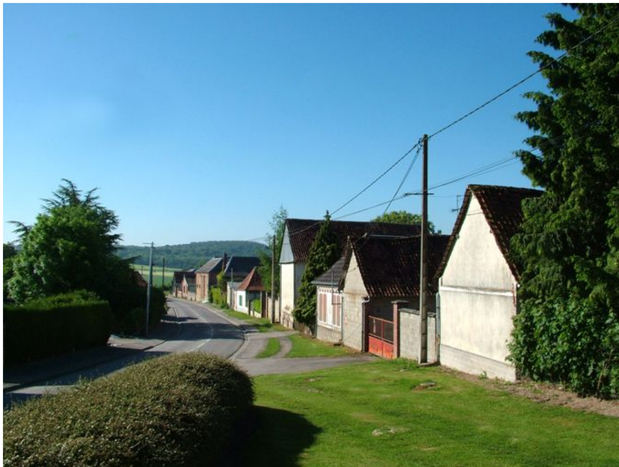
Vue de la rue Principale vers le sud.
