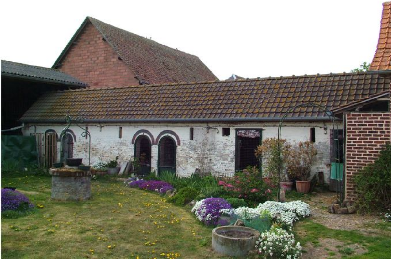
Ancienne ferme, 5 rue Principale, fin du 19e siècle : puits et étables de fond de cour.
