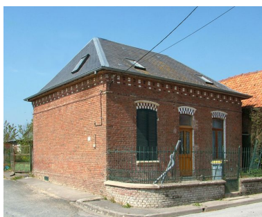
Maison, 3 rue Principale, début du 20e siècle. Phot. Frédéric Fournis IVR22_20108001283NUCA
