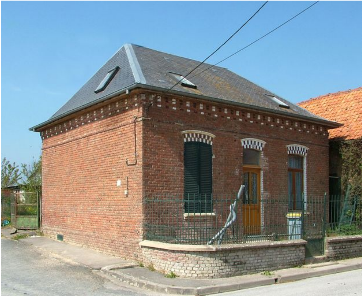
Maison, 3 rue Principale, début du 20e siècle.
