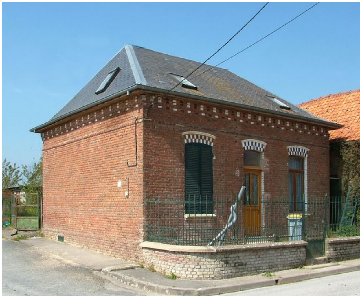
Maison, 3 rue Principale, début du 20e siècle.
