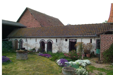
Ancienne ferme, 5 rue Principale, fin du 19e siècle : puits et étables de fond de cour. Phot. Frédéric Fournis IVR22_20108001285NUCA
