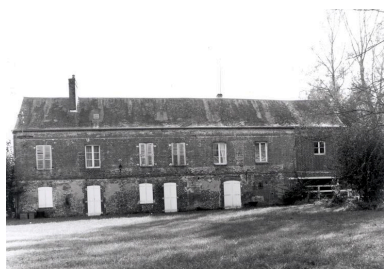
Vue d'ensemble sud-ouest du moulin.
