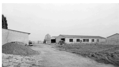
Vue générale des ateliers de charpente, construits à
