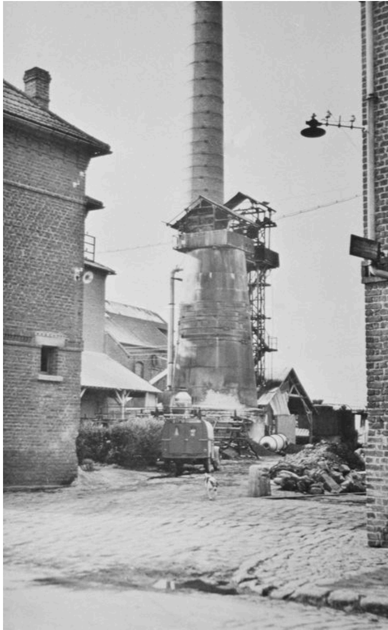
Le four à chaux et la cheminée de la sucrierie (AP).
