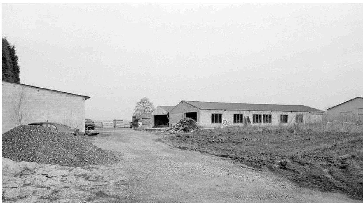
Vue générale des ateliers de charpente, construits à l'emplacement des ateliers de production de l'ancienne sucrierie.
