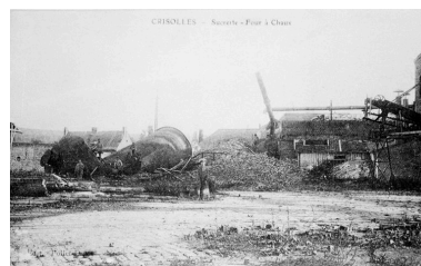
La sucrerie après les bombardements de 1918 (AP). Phot. Bertrand Fournier IVR22_20006000473ZB
