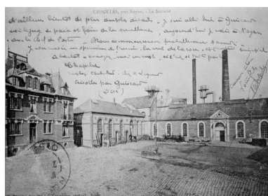
Les ateliers de la sucrierie datant de 1863 donnant sur la cour du logement patronal, situé à gauche, avant 1914 (AP). Phot. Bertrand Fournier IVR22_20006000467ZB
