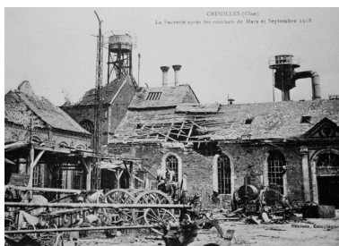
La sucrerie après les bombardements de 1918 (AP). Phot. Bertrand Fournier IVR22_20006000474ZB
