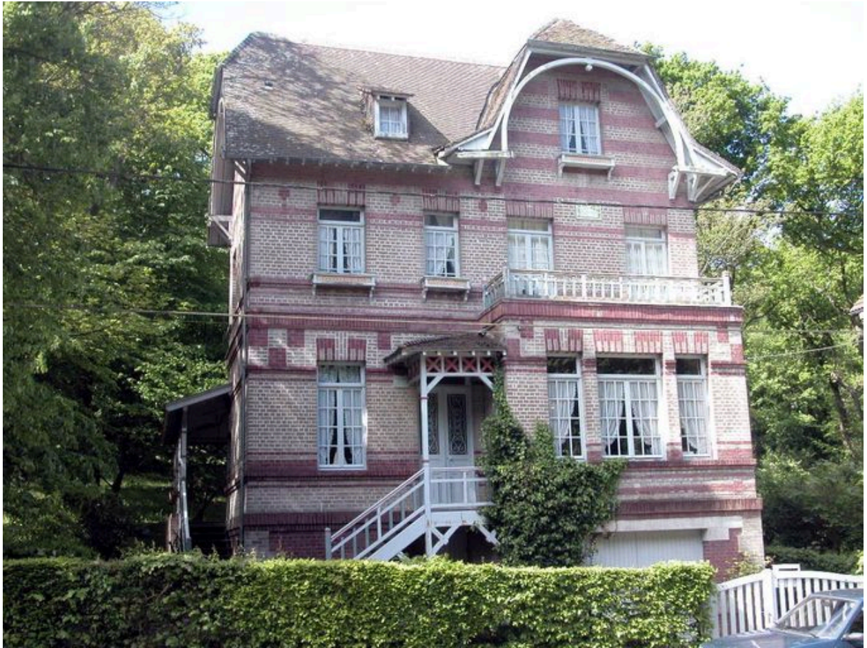
Vue d'ensemble depuis l'avenue.
