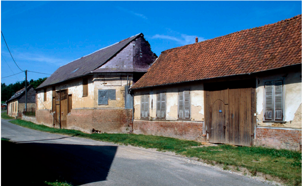
Façade antérieure en 1999, vue du sud-est : au premier plan le café et dans son prolongement, une grange.
