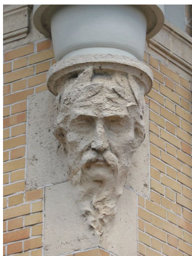
Culot sculpté de la tourelle d'angle en échauguette. Phot. Bertrand Fournier IVR22_20088015079NUCA
