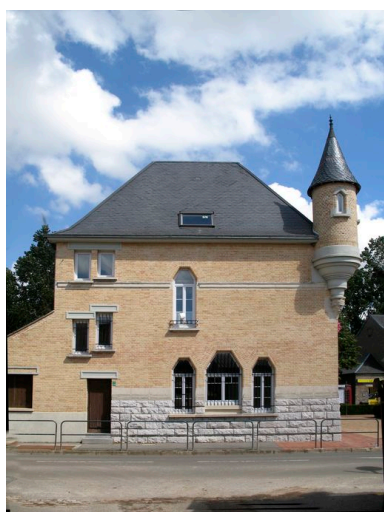
Élévation latérale sud. Phot. Bertrand Fournier IVR22_20088015076NUCA
