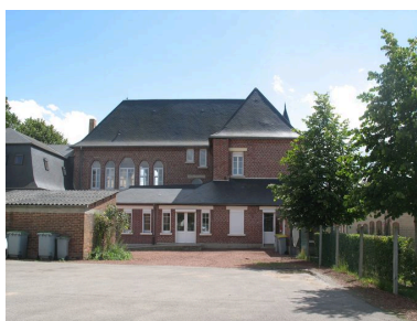
Façade postérieure. Phot. Bertrand Fournier IVR22_20088015080NUCA
