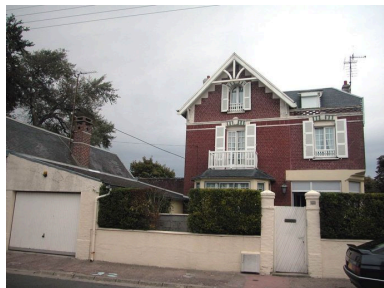
Vue d'ensemble depuis la rue du Capitaine-Guy-Dath. Phot. Elisabeth Justome IVR22_20048001625NUCA
