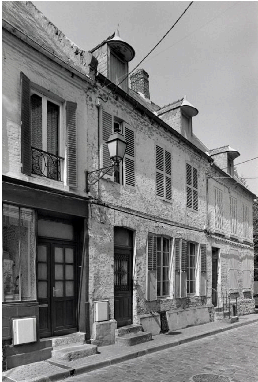
Vue de la façade principale sur rue.
