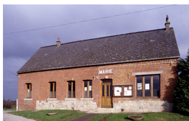
3 rue de l'Eglise, maison (non étudiée) acquise vers 1955 pour servir de mairie. Phot. Christiane Riboulleau IVR22_19930201337ZA
