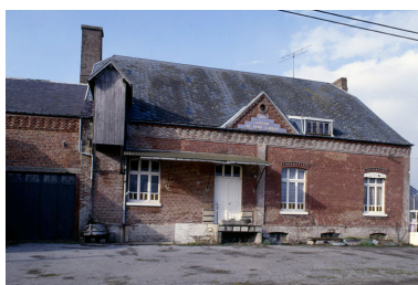
15 rue de la Laiterie : laiterie de Fesmy-l'Abbaye (non étudiée) : vue de la façade datée 1901. Phot. Christiane Riboulleau IVR22_19930201338ZA
