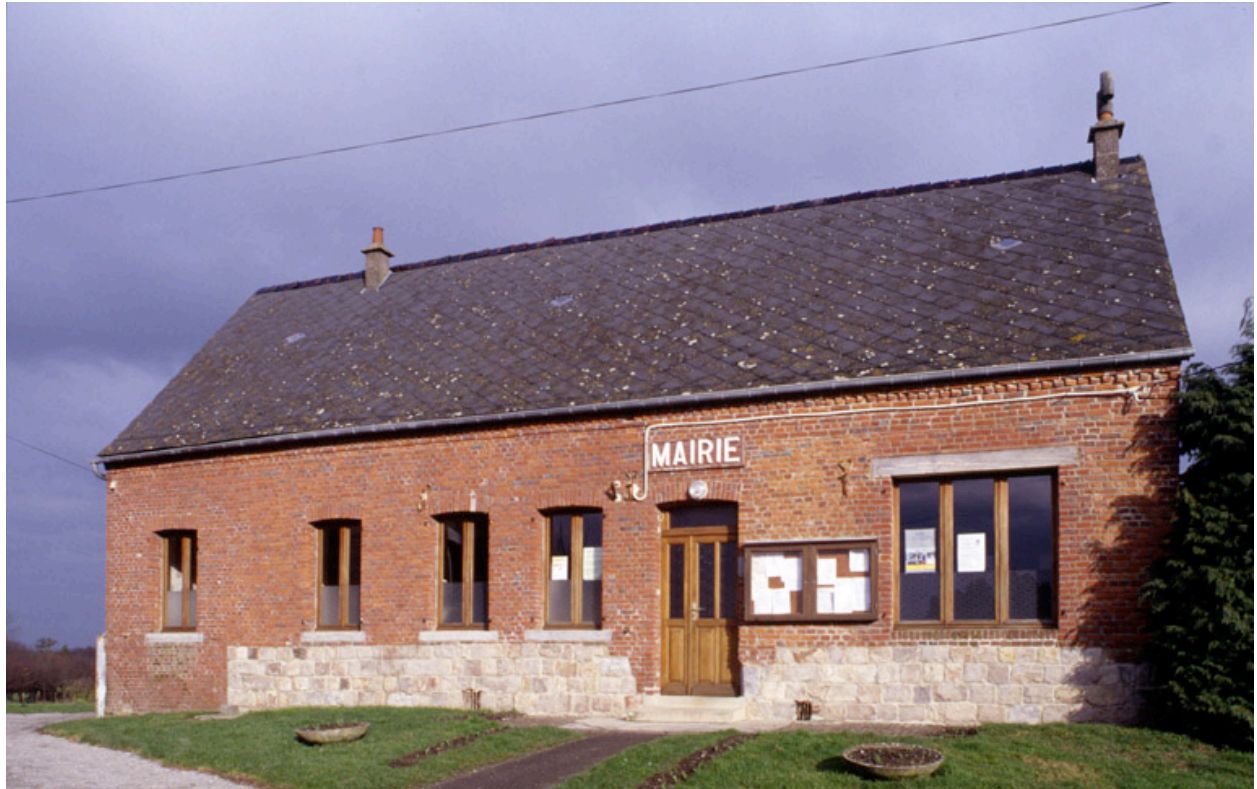
3 rue de l'Eglise, maison (non étudiée) acquise vers 1955 pour servir de mairie.
