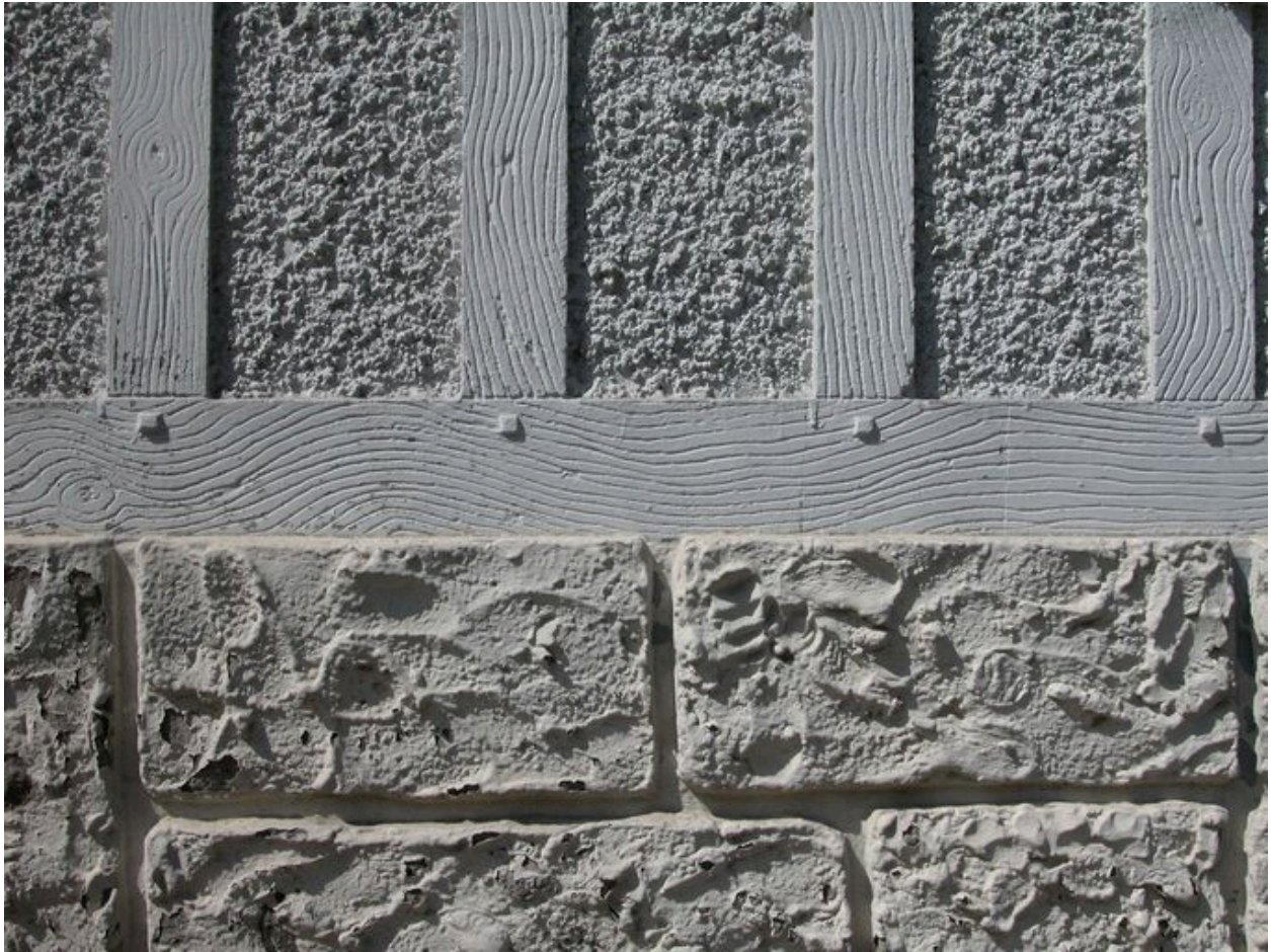
Détail du revêtement de la maison située 86 rue Anguier-du-Peuple (1969 AI 278).
