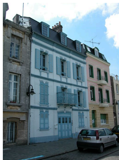
Maison ou immeuble, 13 quai Blavet (AI 162). Phot. Elisabeth Justome IVR22_20058003704NUCA
