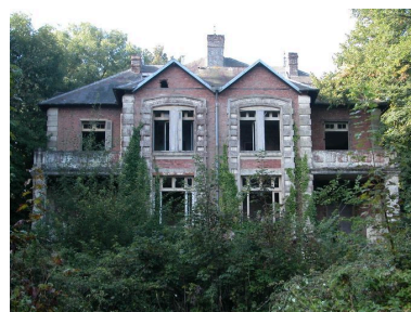
Maison, avenue Romain- Michel, détruite en cours d'étude. Phot. Elisabeth Justome IVR22_20058003692NUCA
