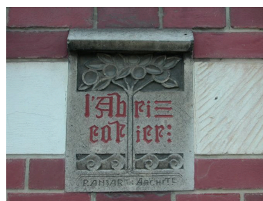
Signature de l'architecte Ansart, maison dite l'Abri Côtier, 7 quai Blavet (AI 172). Phot. Elisabeth Justome IVR22_20058003701NUCA
