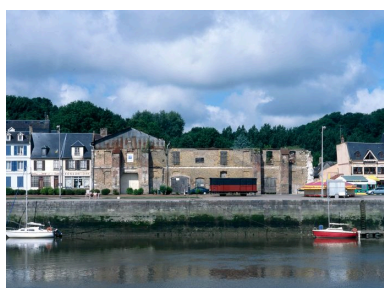
Le grenier à sel sur le quai Lejoille à Saint-Valery-sur-Somme, depuis la digue du Nord. Phot. Marie-Laure Monnehay-Vulliet IVR22_20038000515XA
