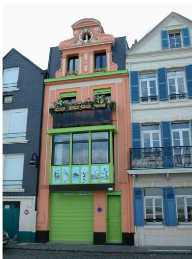
Maison, 45 quai Blavet (AI 143). Phot. Elisabeth Justome IVR22_20058003706NUCA
