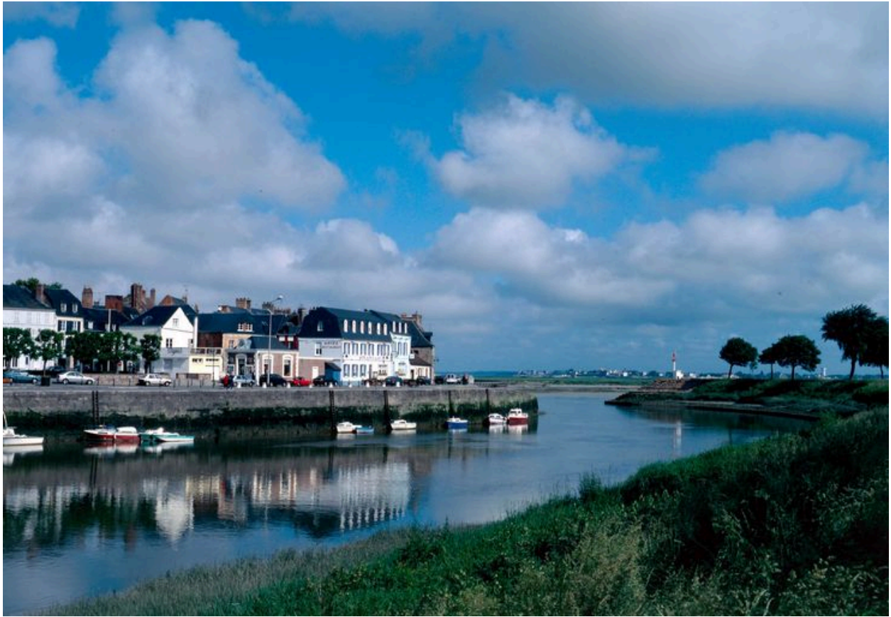
Vue d'ensemble vers l'avant-port depuis la digue du Nord.
