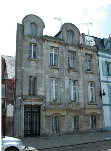
Maison ancienne remaniée en façade, quai Blavet (AI 163). Phot. Elisabeth Justome IVR22_20058003703NUCA
