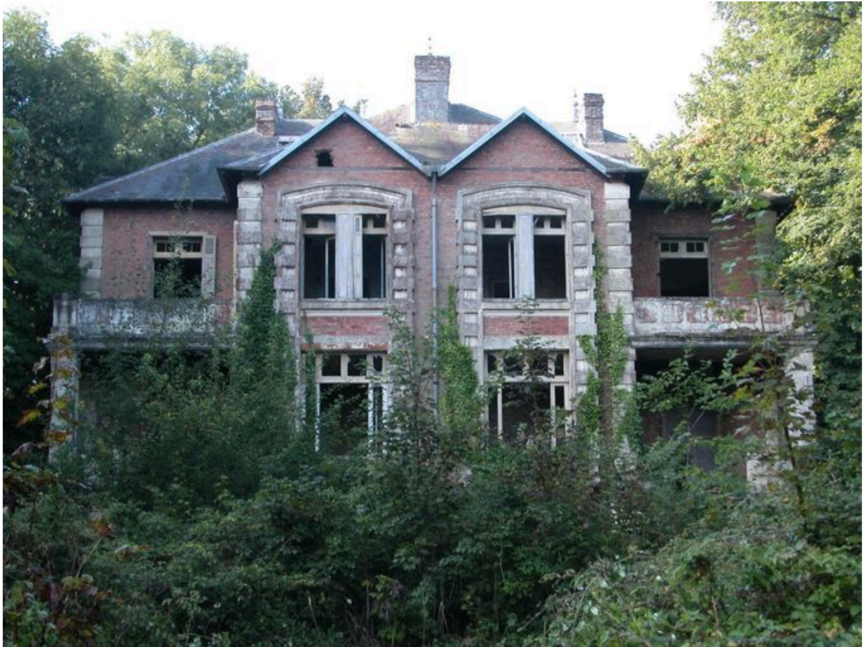
Maison, avenue Romain-Michel, détruite en cours d'étude.
