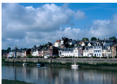
Le quai Lejoille au port de Saint-Valery-sur-Somme, depuis la digue du Nord. Phot. Marie-Laure Monnehay-Vulliet IVR22_20038000514XA
