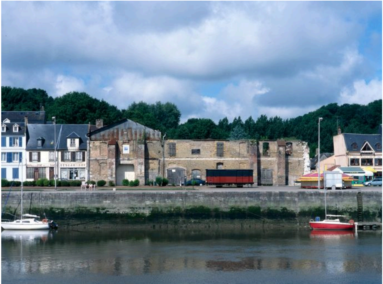
Le grenier à sel sur le quai Lejoille à Saint-Valery-sur-Somme, depuis la digue du Nord.
