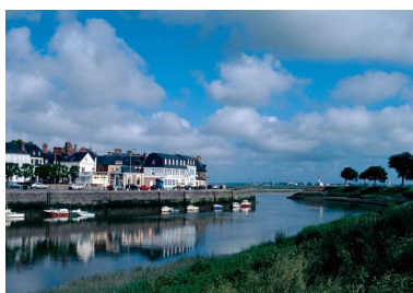
Vue d'ensemble vers l'avant-port depuis la digue du Nord. Phot. Marie-Laure Monnehay-Vulliet IVR22_20038000510XA
