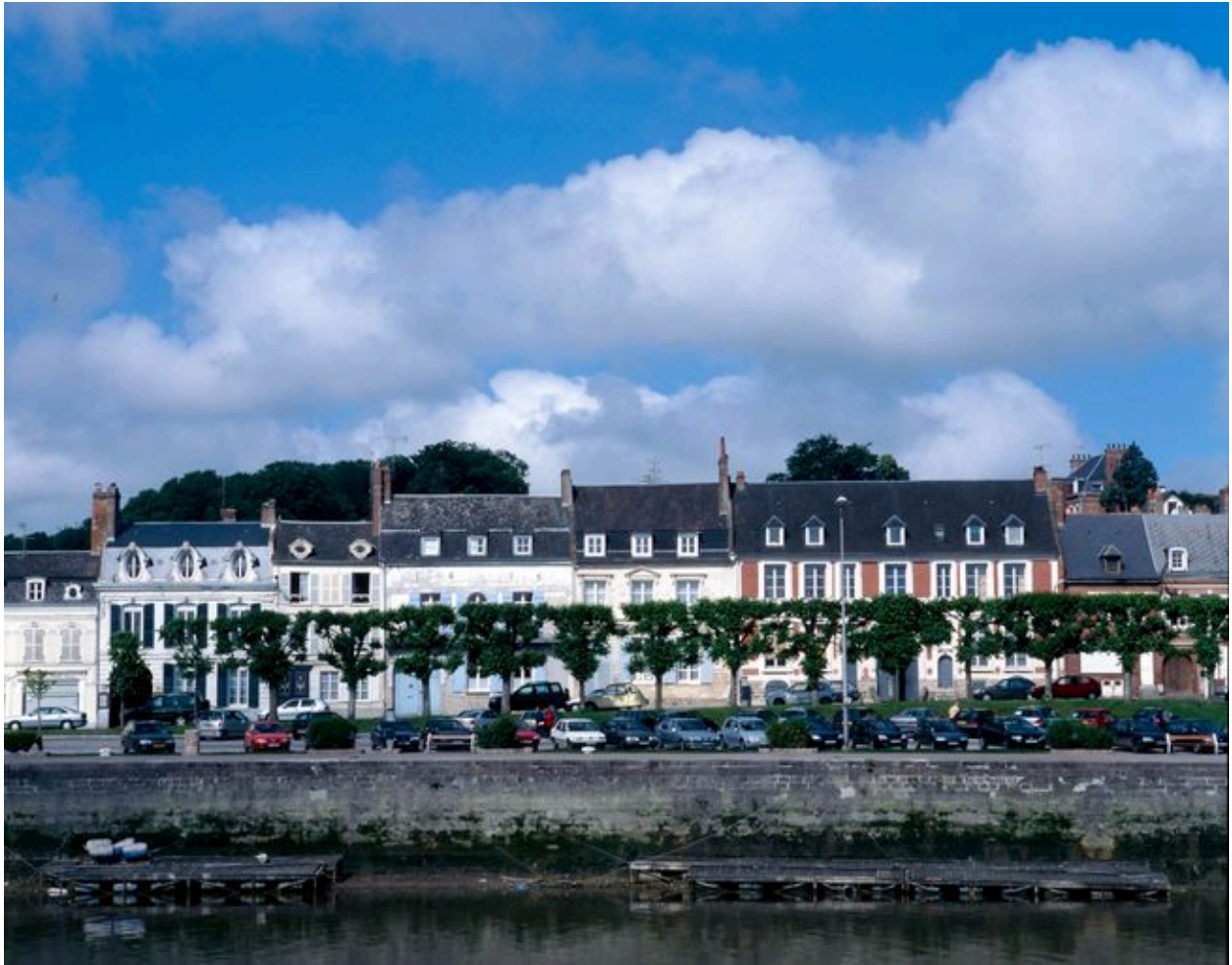
Ensemble de maisons de notables, quai Perrée à Saint-Valery-sur-Somme.
