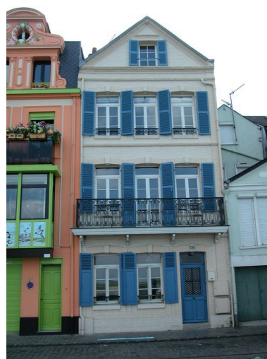
Maison, 47 quai Blavet (AI 142). Phot. Elisabeth Justome IVR22_20058003707NUCA
