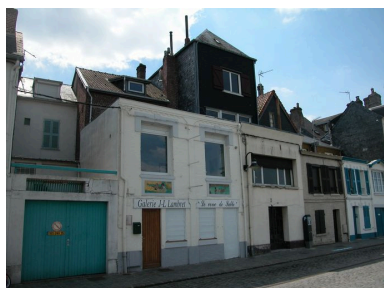
Façades postérieures des maisons de la rue de la Ferté et avancées sur le quai Blavet (AI 153, 154, 155). Phot. Elisabeth Justome IVR22_20058003705NUCA
