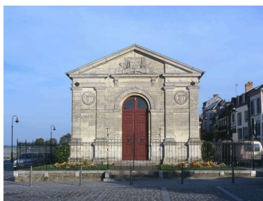
Le tribunal de commerce, place des Pilotes. Phot. Irwin Leullier IVR22_20008000626XA
