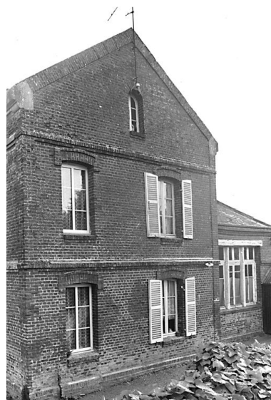
Elévation postérieure. Phot. Xavier-Philippe Guiochon IVR22_19980201232Z
