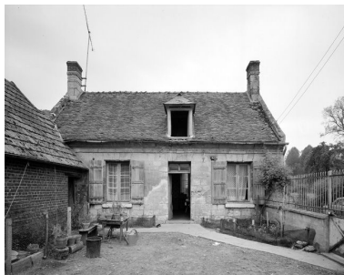
Elévation antérieure. Phot. Jean-Michel Perrin IVR22_19856000835V
