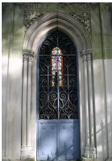
Vue rapprochée de la porte en fonte ouvragée. Phot. Caroline Vincent IVR22_20078000495NUCA
