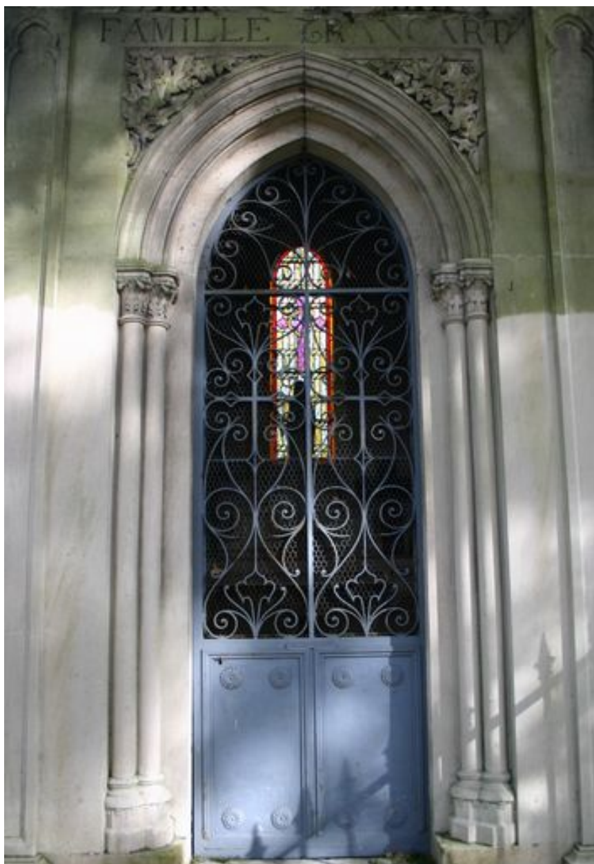
Vue rapprochée de la porte en fonte ouvragée.
