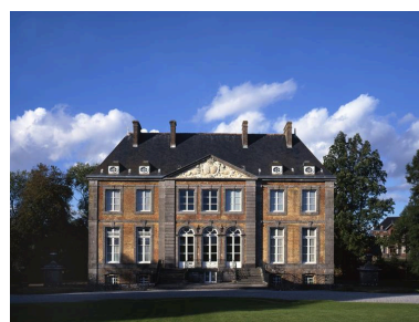
Le logis, vue depuis la cour d'honneur. Phot. Thierry Lefébure IVR22_19950202950VA
