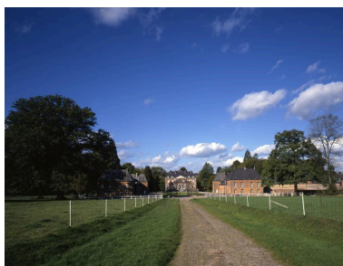
Vue générale, depuis l'avenue. Phot. Thierry Lefébure IVR22_19950202948VA
