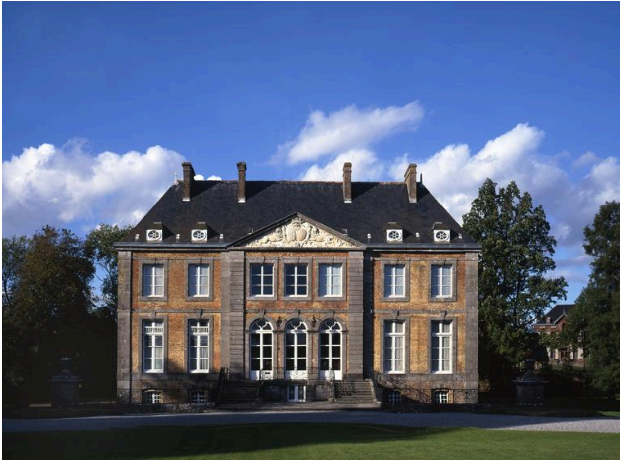
Le logis, vue depuis la cour d'honneur.
