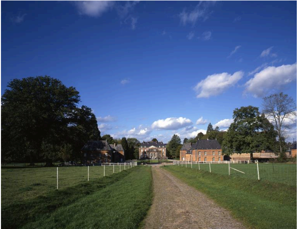
Vue générale, depuis l'avenue.
