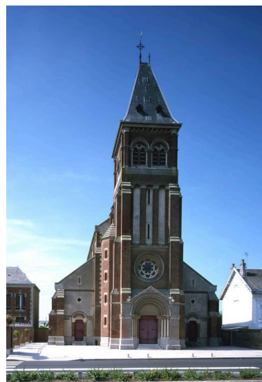
Élévation antérieure. Phot. Marie-Laure Monnehay-Vulliet IVR22_20048000136VA
