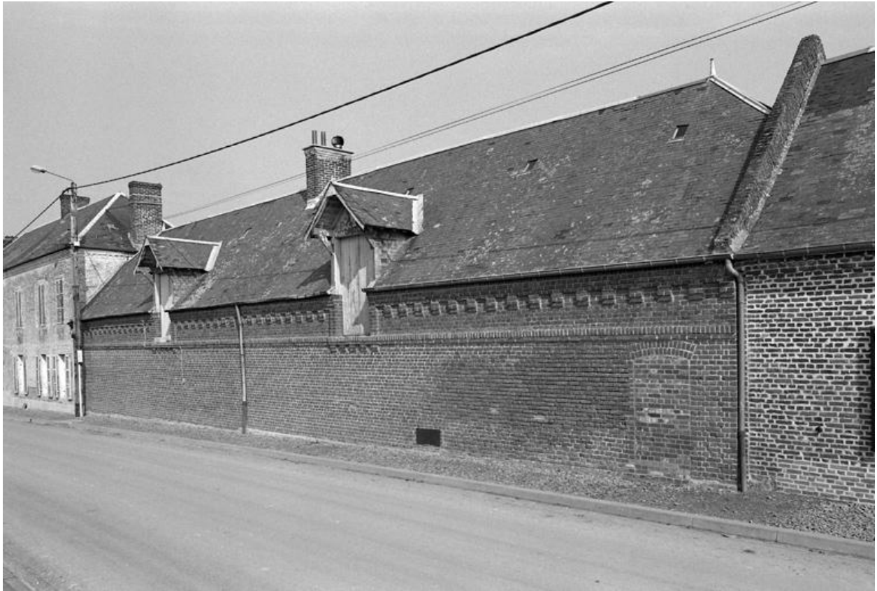
La laiterie. Façade sur la rue.
