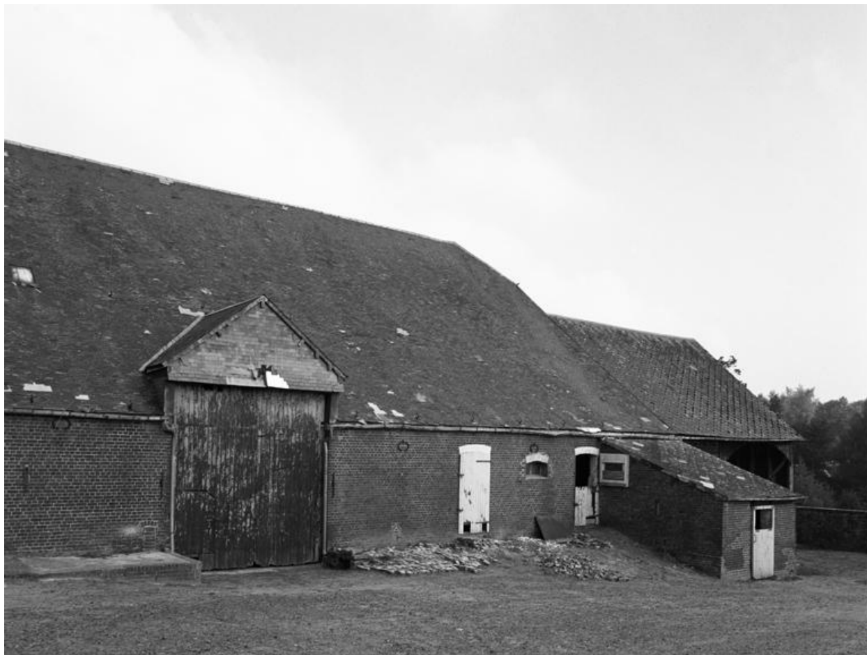
La grange et le hangar. Façades sur la cour.
