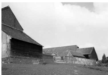
Vue de situation, en contrebas de la cour. Phot. Thierry Lefébure IVR22_19960200615X
