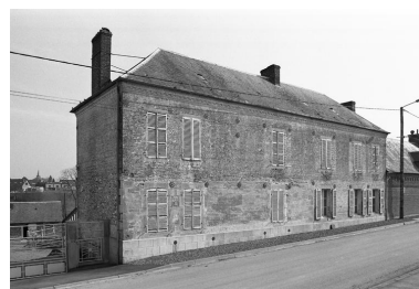
Le logis. La façade sur rue. Phot. Christiane Riboulleau IVR22_19960200368Z
