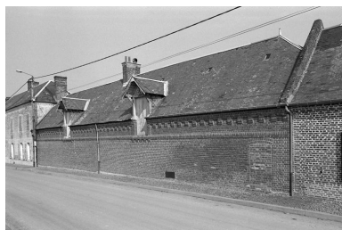
La laiterie. Façade sur la rue. Phot. Christiane Riboulleau IVR22_19960200370Z
