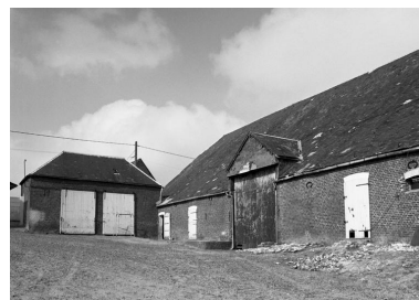
La grange et l'étable. Elévations sur cour. Phot. Thierry Lefébure IVR22_19960200612X
