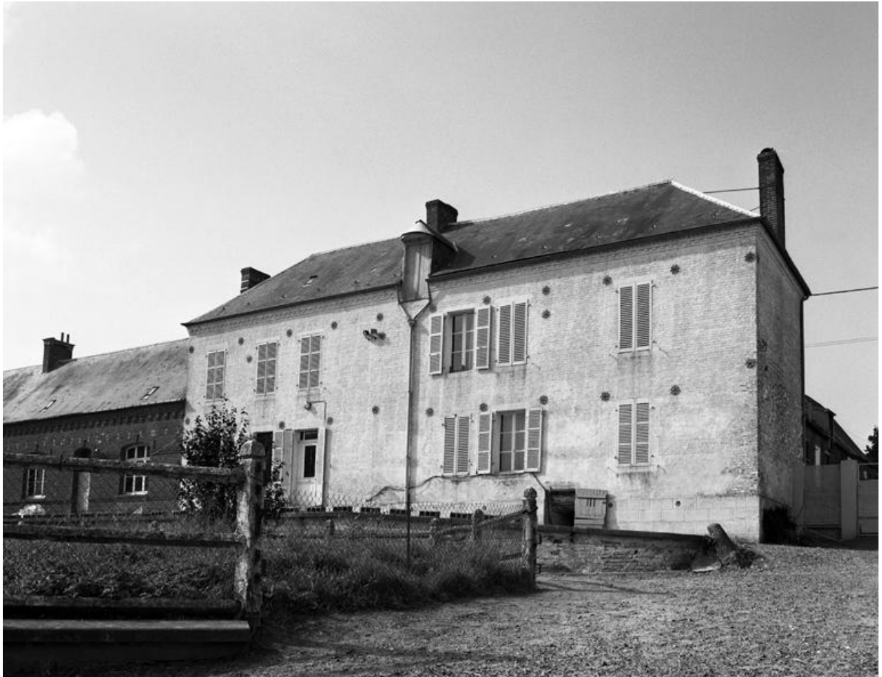
Le logis. Façade sur la cour.
