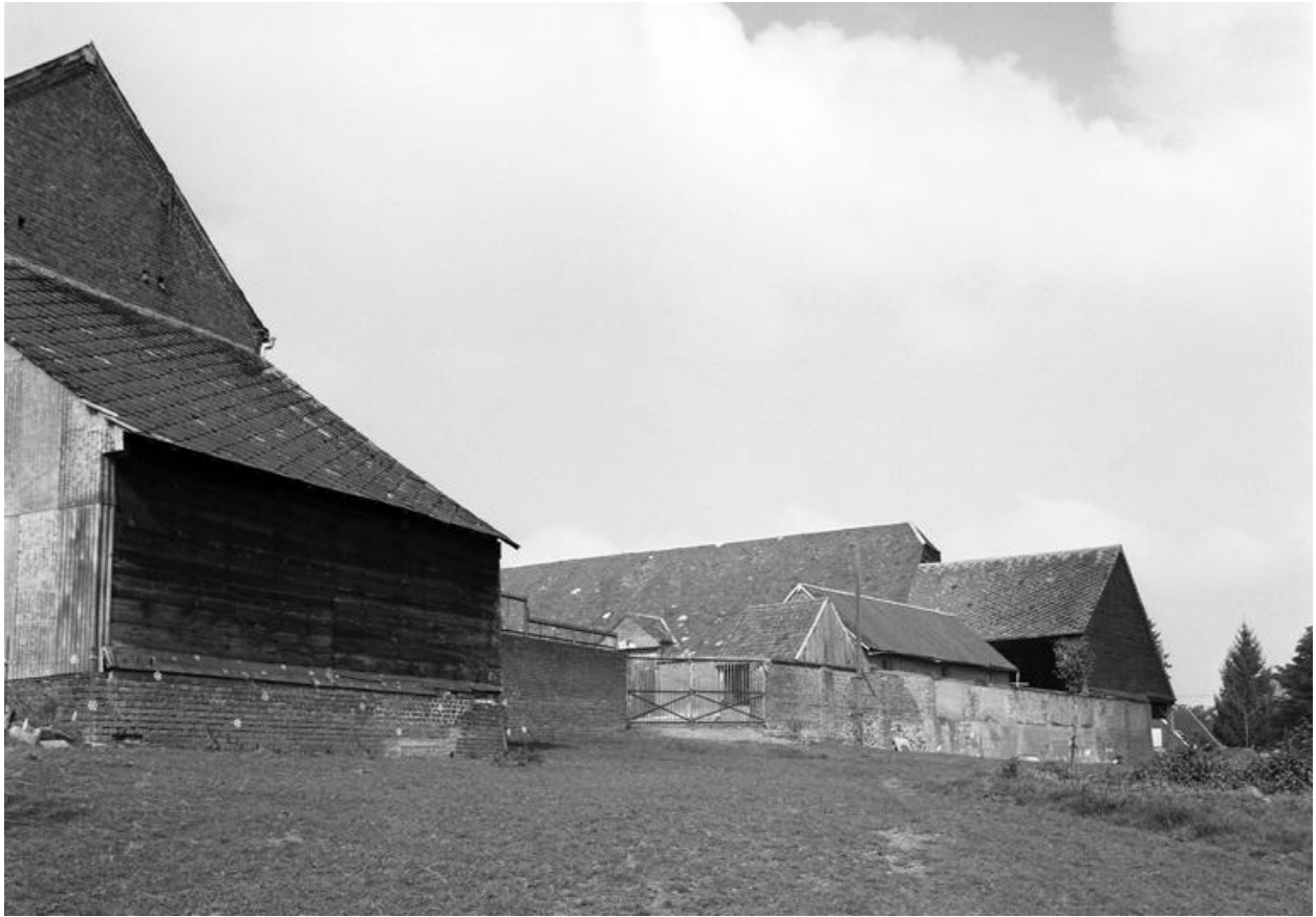
Vue de situation, en contrebas de la cour.
