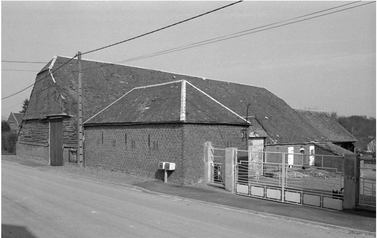
Vue de situation depuis la rue. La grange et l'étable attenante.
